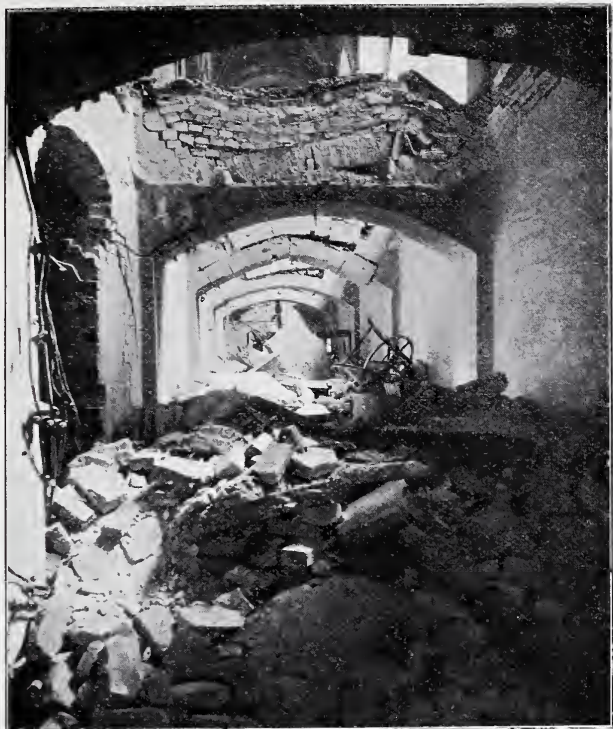
Abb. 2. Flur im Ostflügel des Kellergeschosses.
