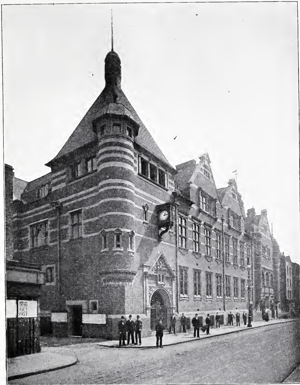
Abb. 6. Volksbücherei, Bade- und Waschanstalt in Shoreditch, London. Gesamtansicht.
