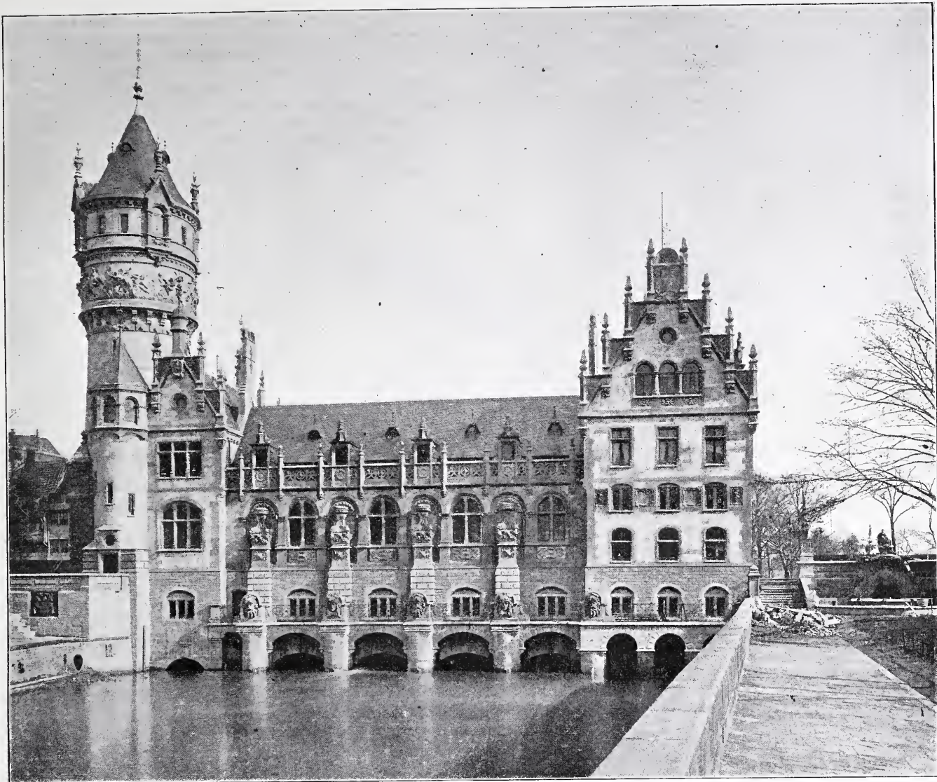
Abb. 5. Ansicht von der Unterwasserseite. Das neue Flusswasserwerk in Hannover.
