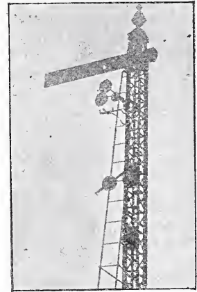
Abb. 4. 8 m vom links stehenden Signal.
