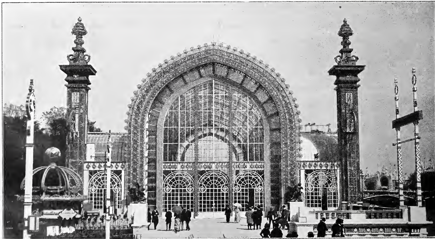
Abb. 6. Kopfbau des Ausstellungsgebäudes für Gartenbau und Baumzucht.
