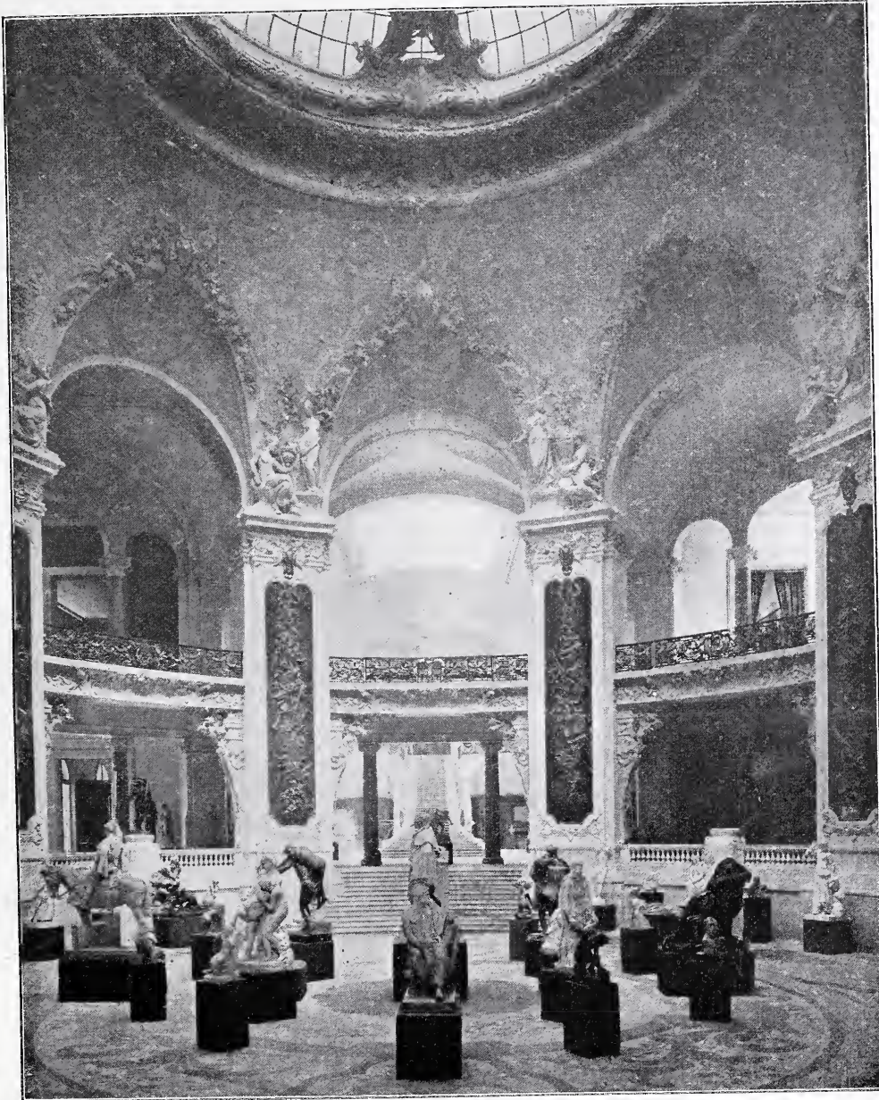
Abb. 6. Kuppelraum des großen Kunstpalastes am Eingang von der Avenue d'Antin.
