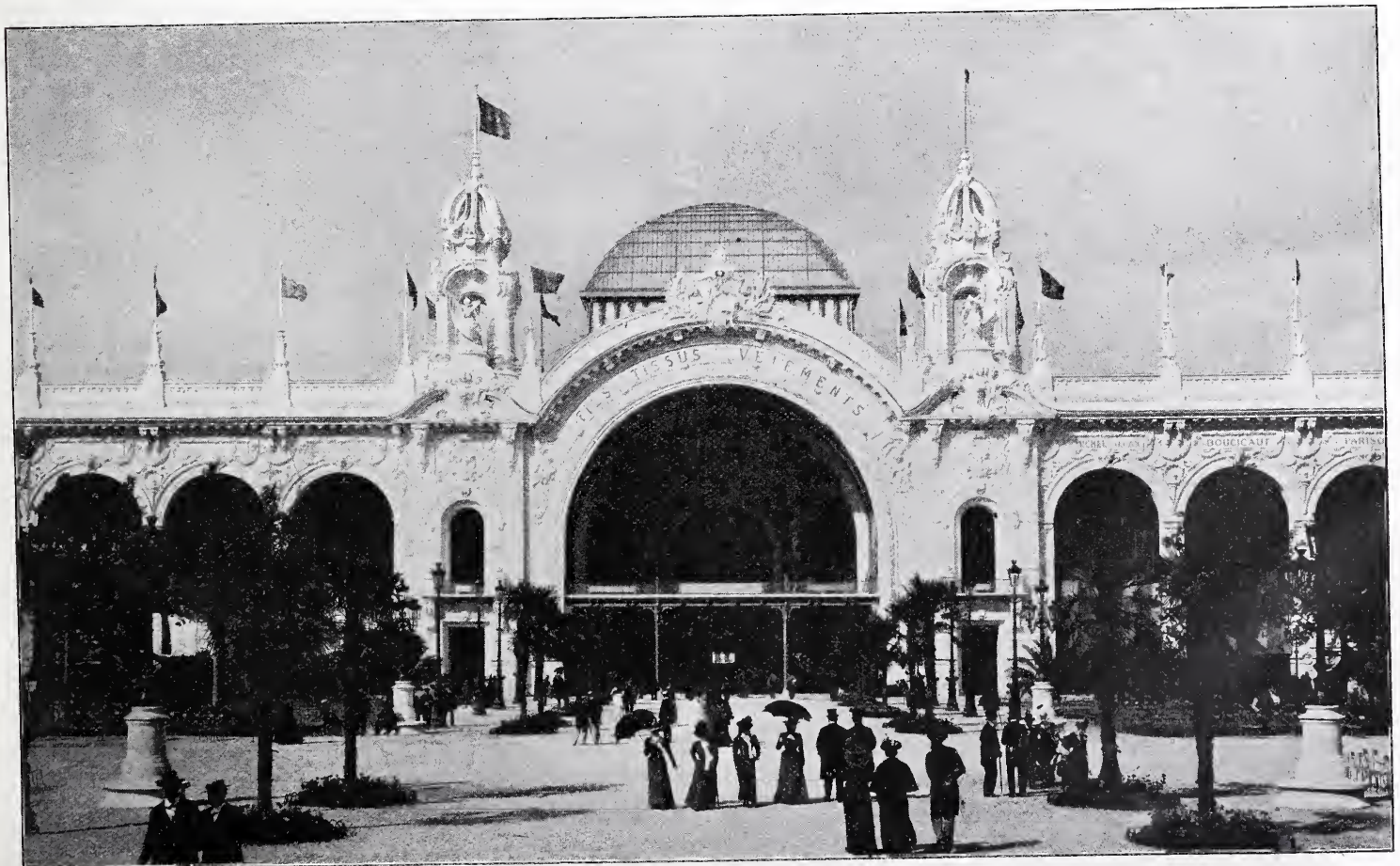
Abb 8. Ausstellungsgebäude auf dem Marsfelde. Mitteldurchgang nach der Avenue Rapp hin.
