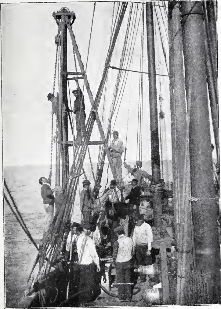
Abb. 1. Aufstellung einer Plattform im La Plata.
