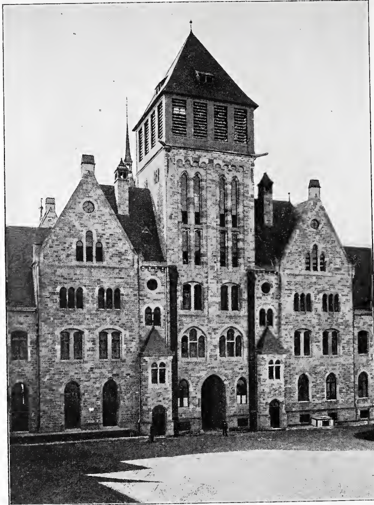
Abb. 4. Fernsprechthurm. Das neue Reichspostgebäude in Strafsburg i. E.
