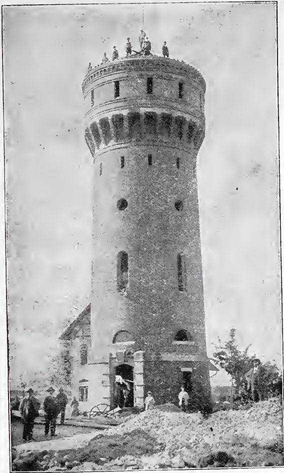
Abb. 1. Wasserwerk mit Hochbehälter für 30 000 Liter Stundenleistung.
