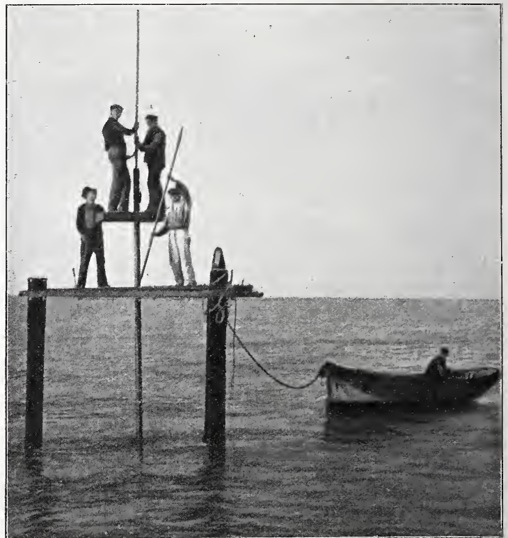
Abb. 3. Grundbohrung auf dem Banco Ortiz 38 km von der nächsten Küste.
