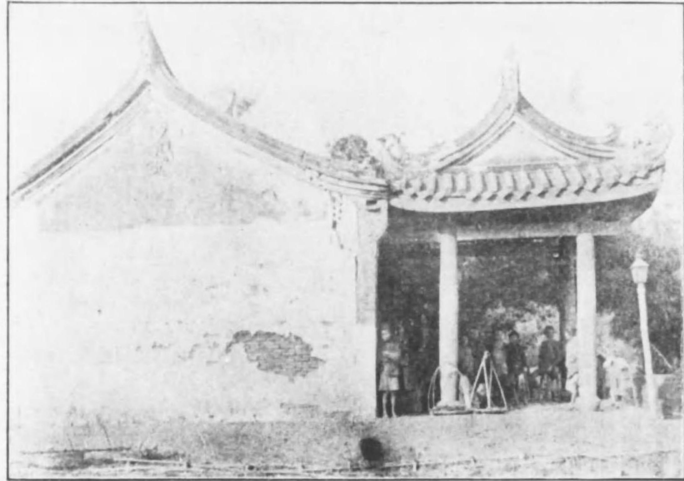
新港福德本殿向ノト接續點被害 (五十第)
