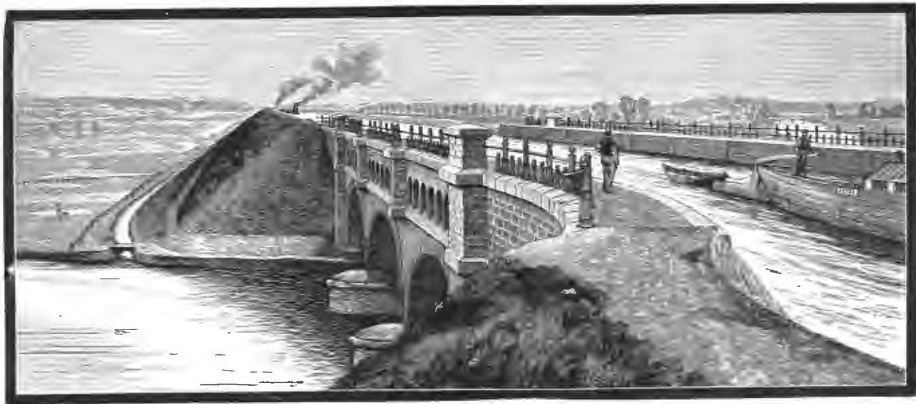
Дортмундъ-Эмскій каналъ. Каналь-мостъ надъ р. Штеверъ, у Ольфена. По рис. Ф. Штольтенберга грав. Ю. Мультановскій.
