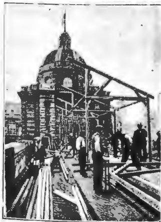
Постройка коридора для прохода обвиняемыхъ изъ тюрьмы въ судъ.
