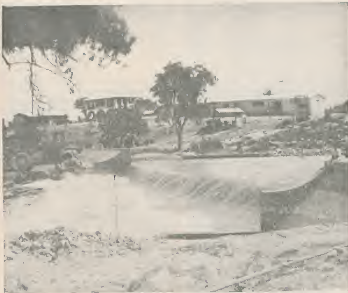
Vista da barragem, da casa de administração e oficinas construídas pelo Ministério da Agricultura na região de Paula Afonso
