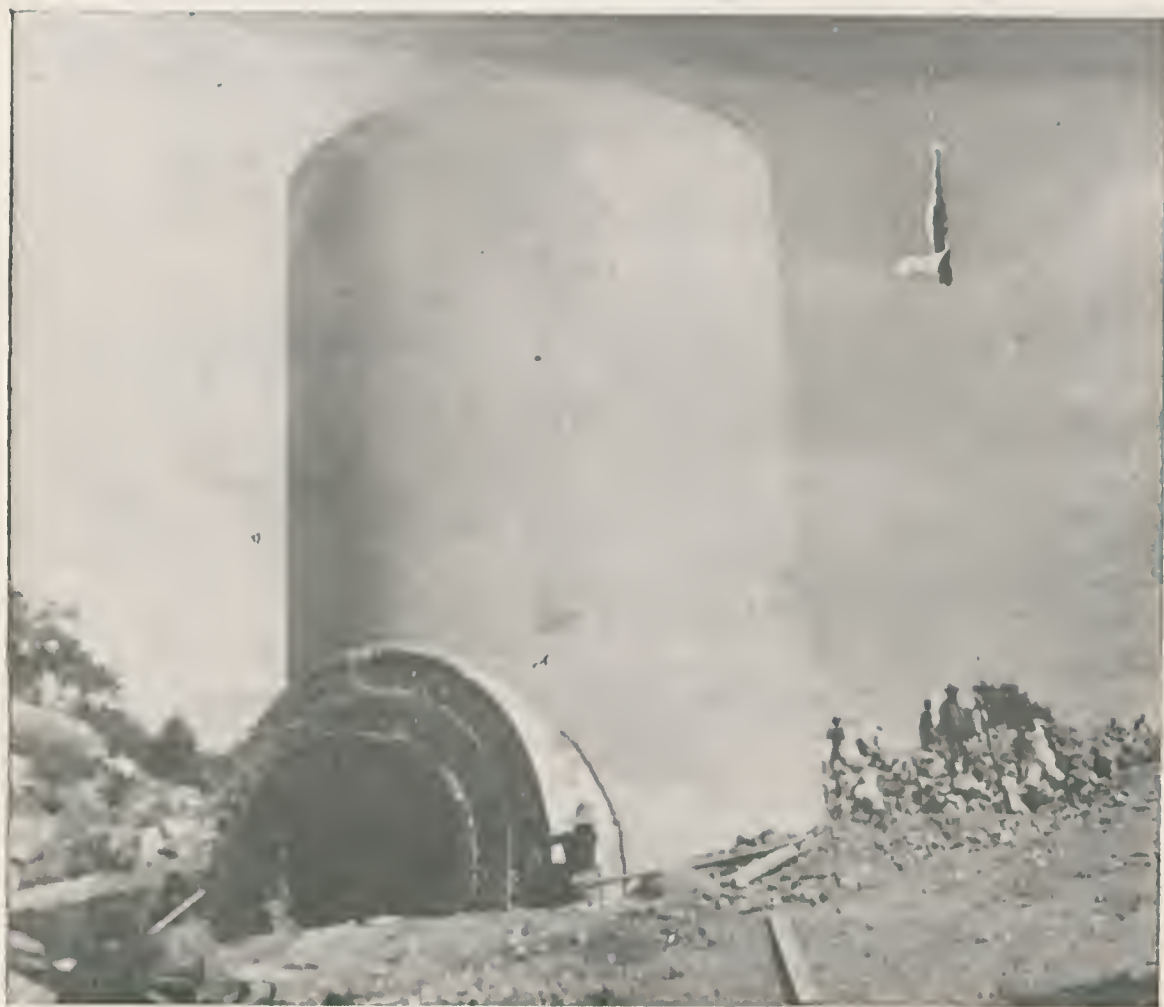
A chaminé de equilibria da usina auxiliar de 5.000 K.W., em construção pela govêrno federal, próximo à famosa cachoeira nordestina
