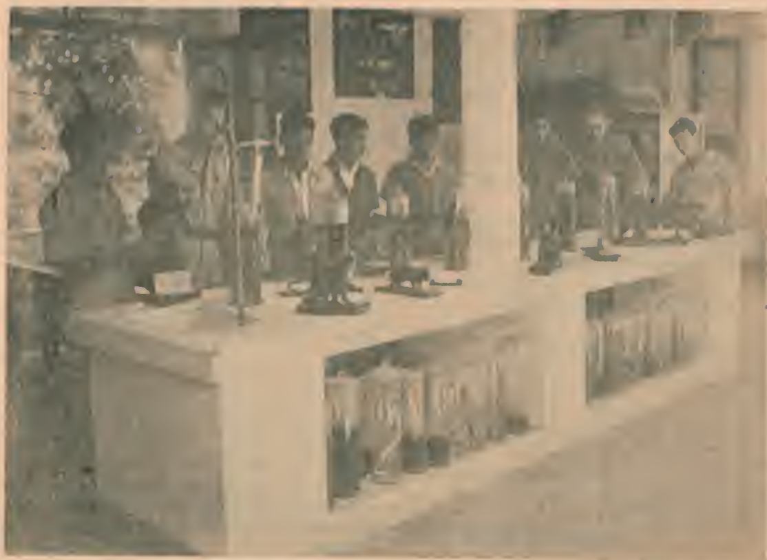
Uma aula de laboratório (Pavilhão Miguel Calmon)
