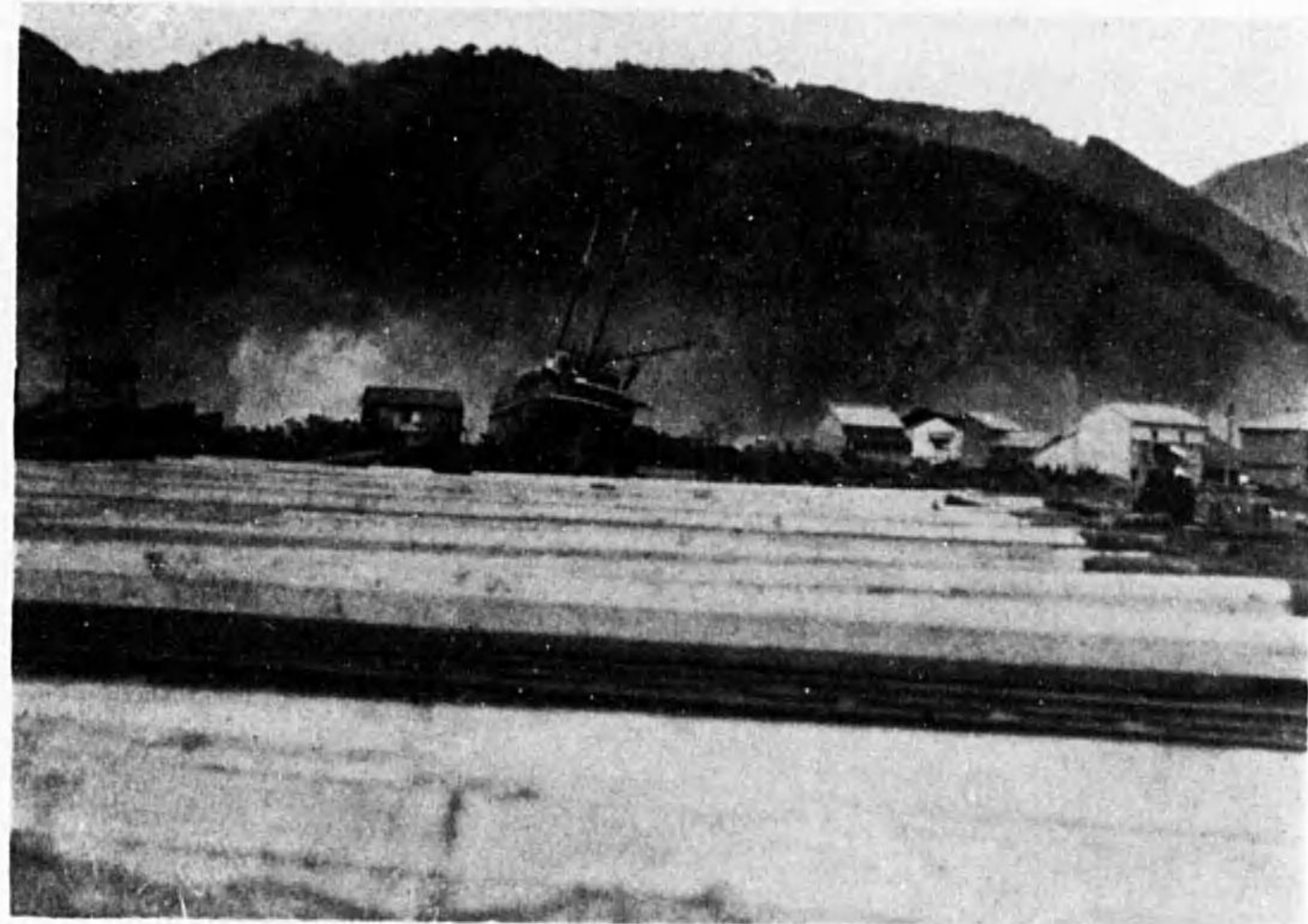
第八圖 岩手縣釜石町、發動機船海岸より數町押し上げらる、この附近火災起る。
