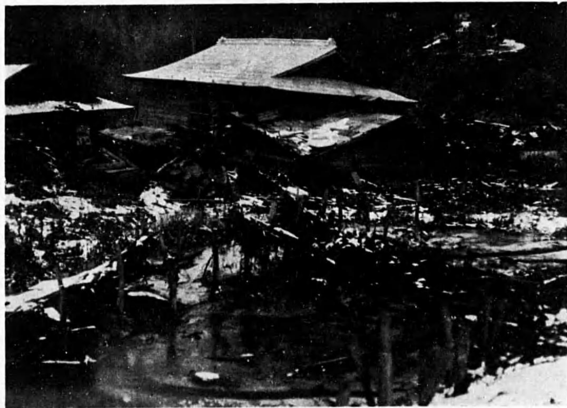
第十一圖 岩手縣田老村、民家の倒壊
