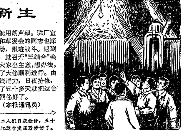
工人们日夜抢修，五十多天把这台变压器修好了。
