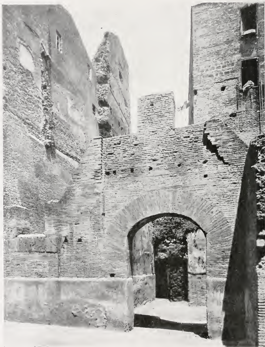
STAZIONE DI VIGILI IN TRASTEVERE -- INTERNO.
