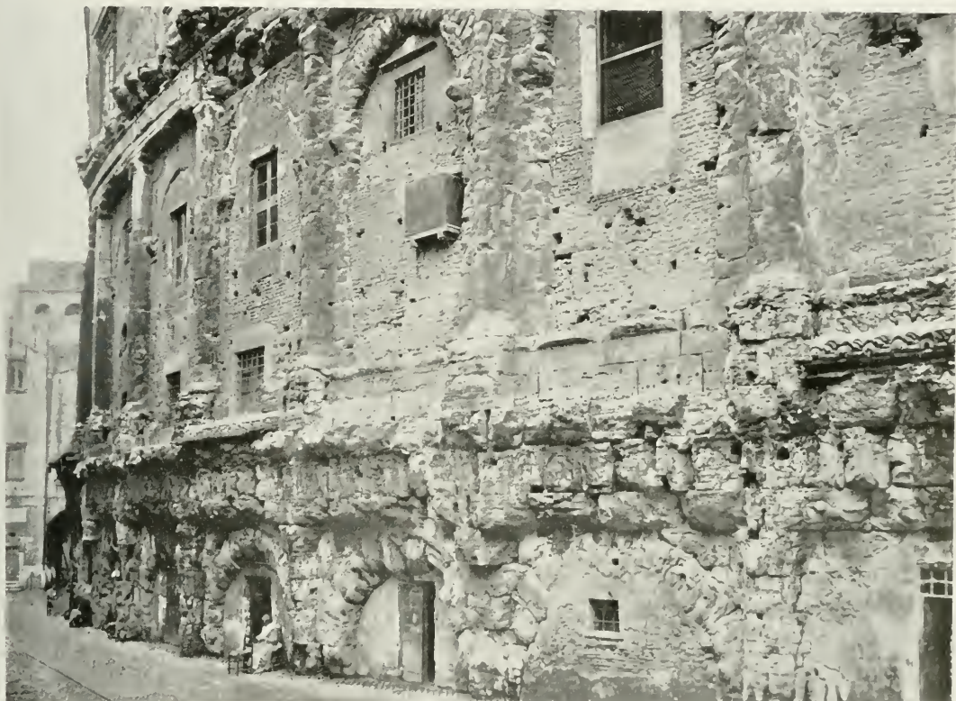
AVANZI DEL TEATRO DI MARCELLO IN PIAZZA MONTANARA.
