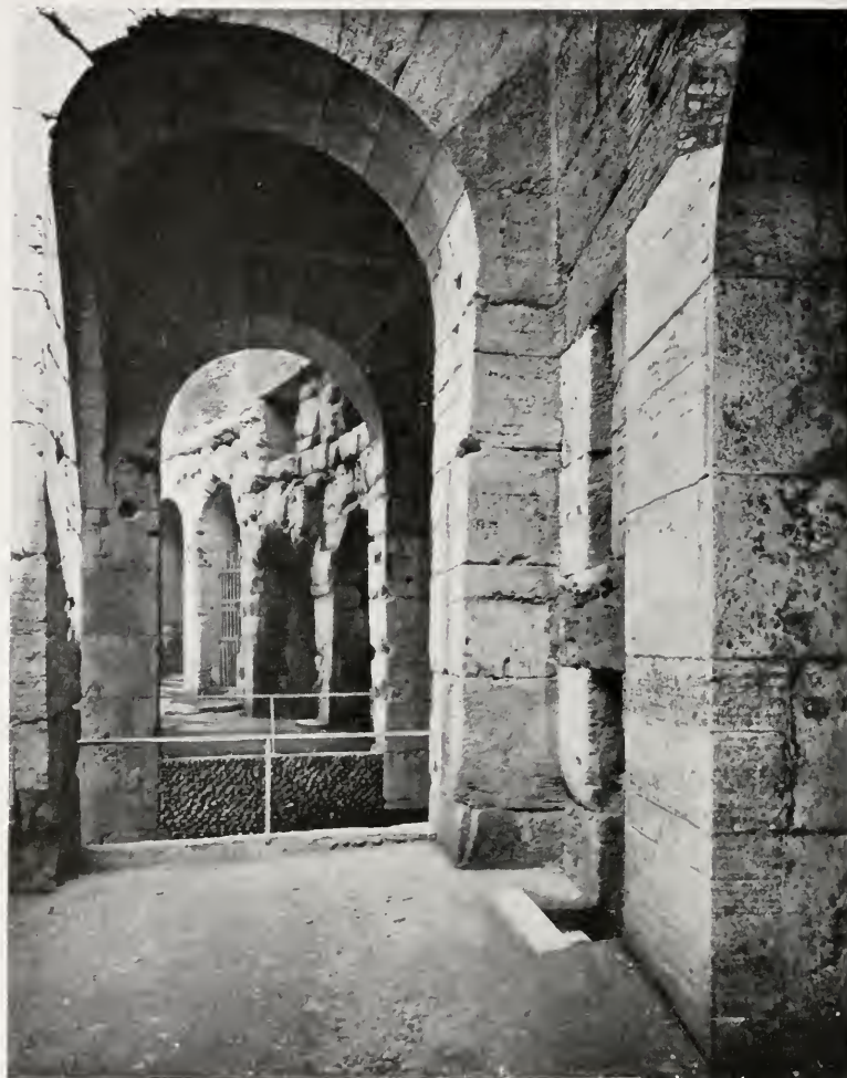
CORRIDOIO INTERNO DEL COLOSSEO.
