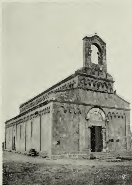
Uta - Chiesa di S. Maria (facciata).
