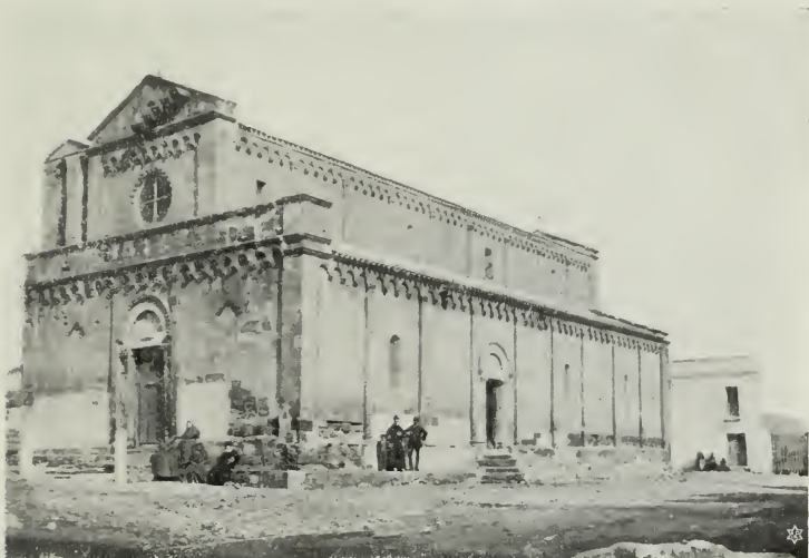
Tratalias - Chiesa di S. ta Maria - facciata e fianco.
