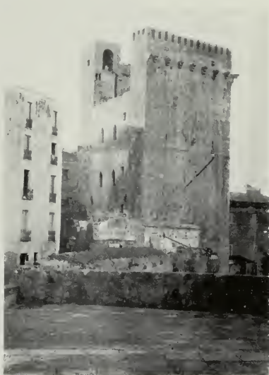
Cagliari - Torre dell'Elefante (durante le demolizioni).
