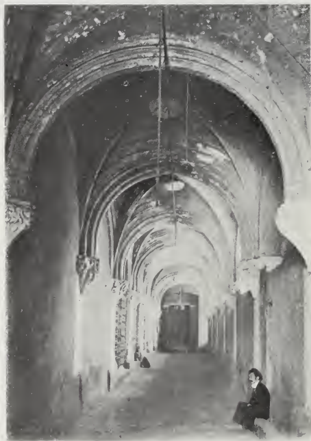
Cagliari - Convento di S. Domenico (braccio).
