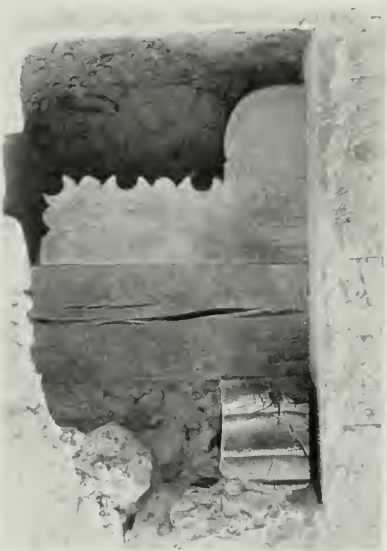
Cagliari - Torre dell'Elefante particolari delle mensole e sottomensole delle travature.
