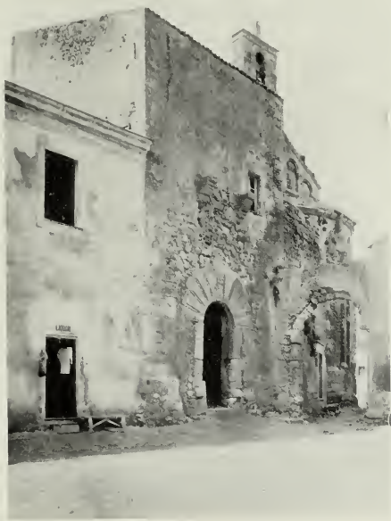
Portotorres - Chiesa di S. Gavino. Abside prima dei restauri.
