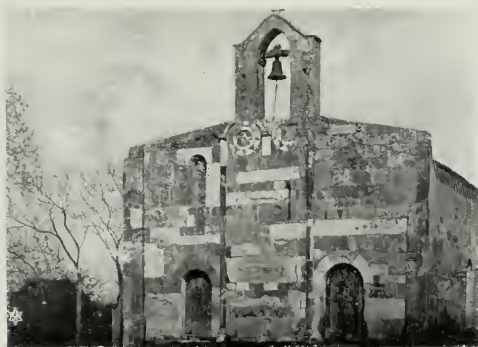
Villaspeciosa - Chiesa di S. Platano.
