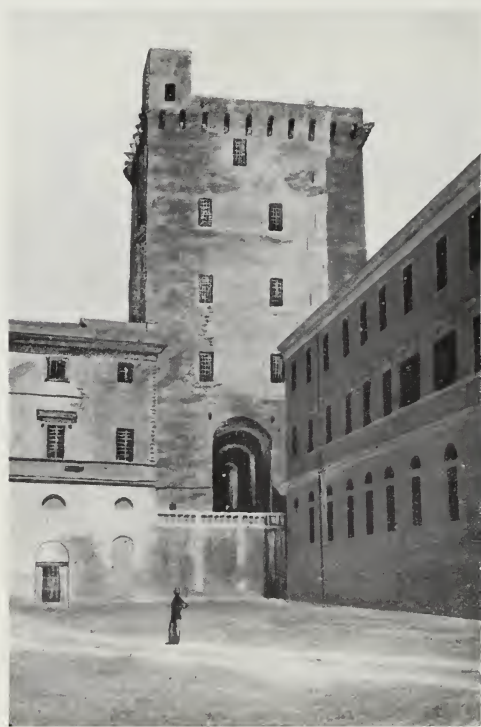
Cagliari - Torre di S. Pancrazio (prima dei restauri).
