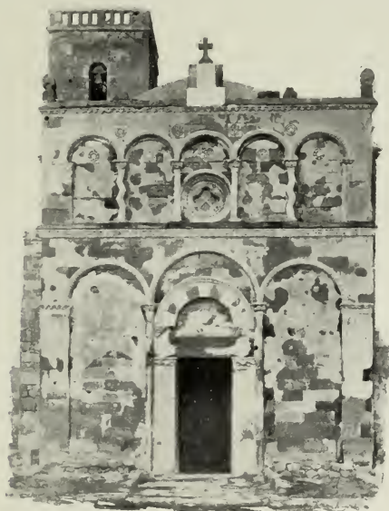
Castelsardo - Chiesa di N. S. di Tergu (facciata).
