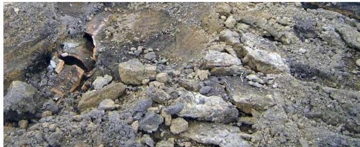
Foto 47. Antiguo tubería del acueducto, en cerámica
