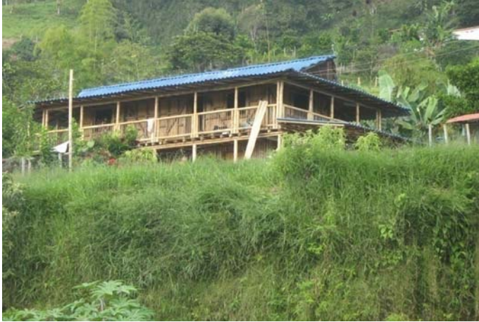
Foto 21. Construcción en guadua con técnicas modernas
