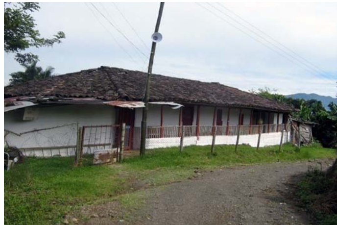
Foto 17. Techo a cuatro aguas
