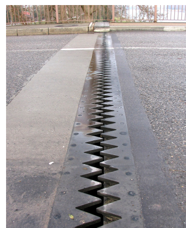
Fig. 4.12: Junto de dilato sur ponto
