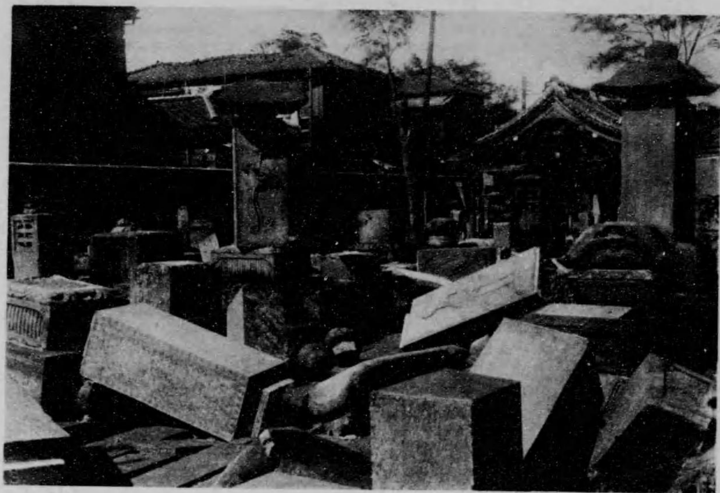
大崎町白金最上寺境内ノ塔石ノ潰倒
