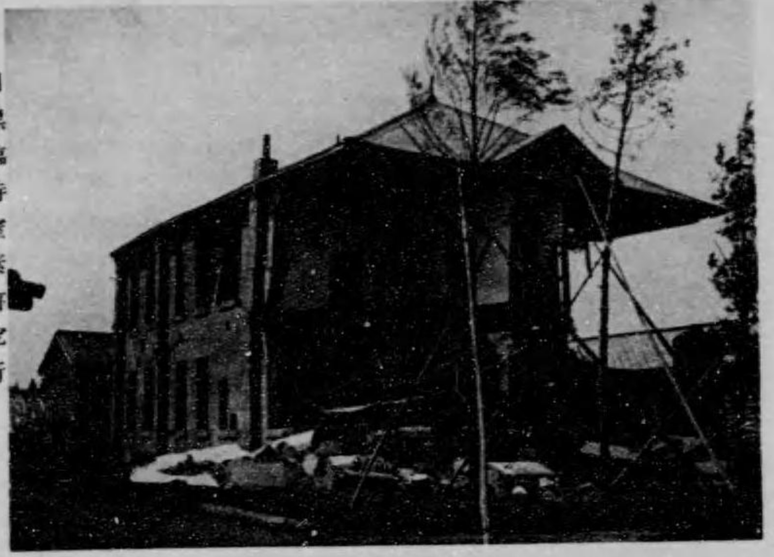
第一圖 煉瓦造建物ノ大破
