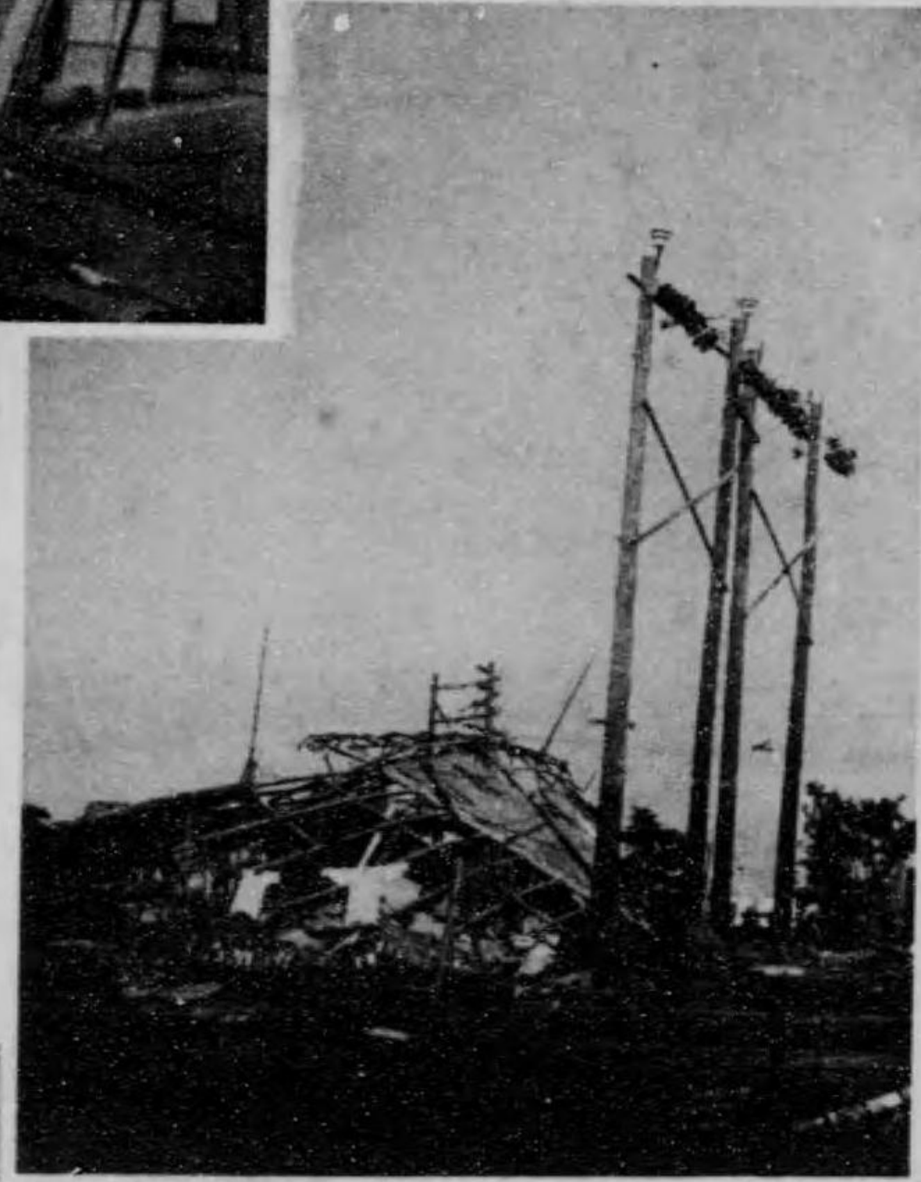
池上東京電燈株式會社 池上變電所ノ倒潰
