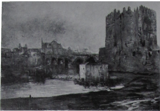
Puente de Córdoba
