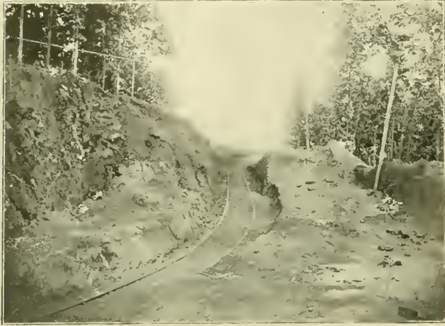
LAKWOOD LINE, ATLANTA.
