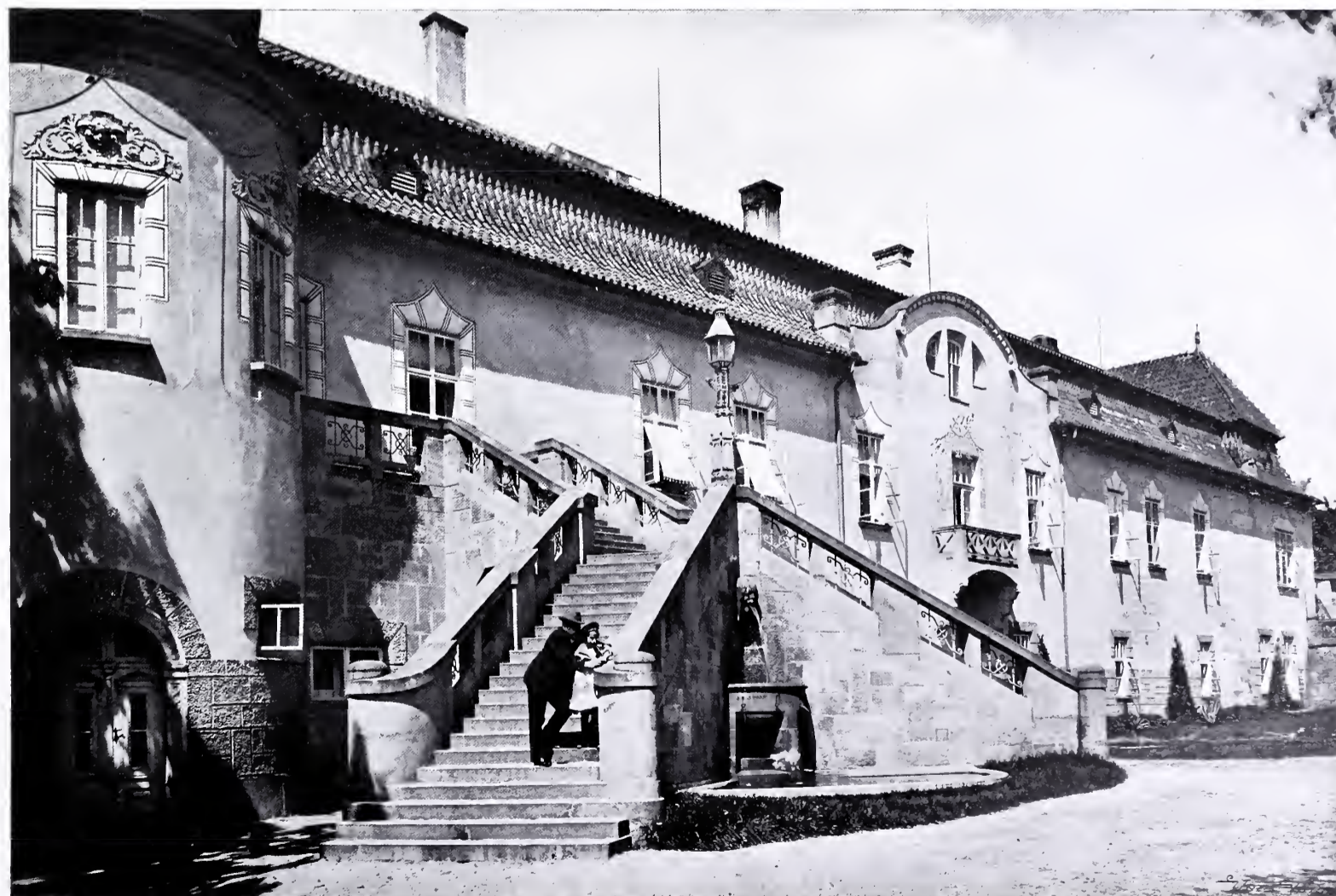
PŘESTAVBA ZÁMKU HOLOVOUSY. — ZAHRADNÍ PRŮČELÍ. Arch. Jan Vejrych, c. k. stav. rada v Praze.
