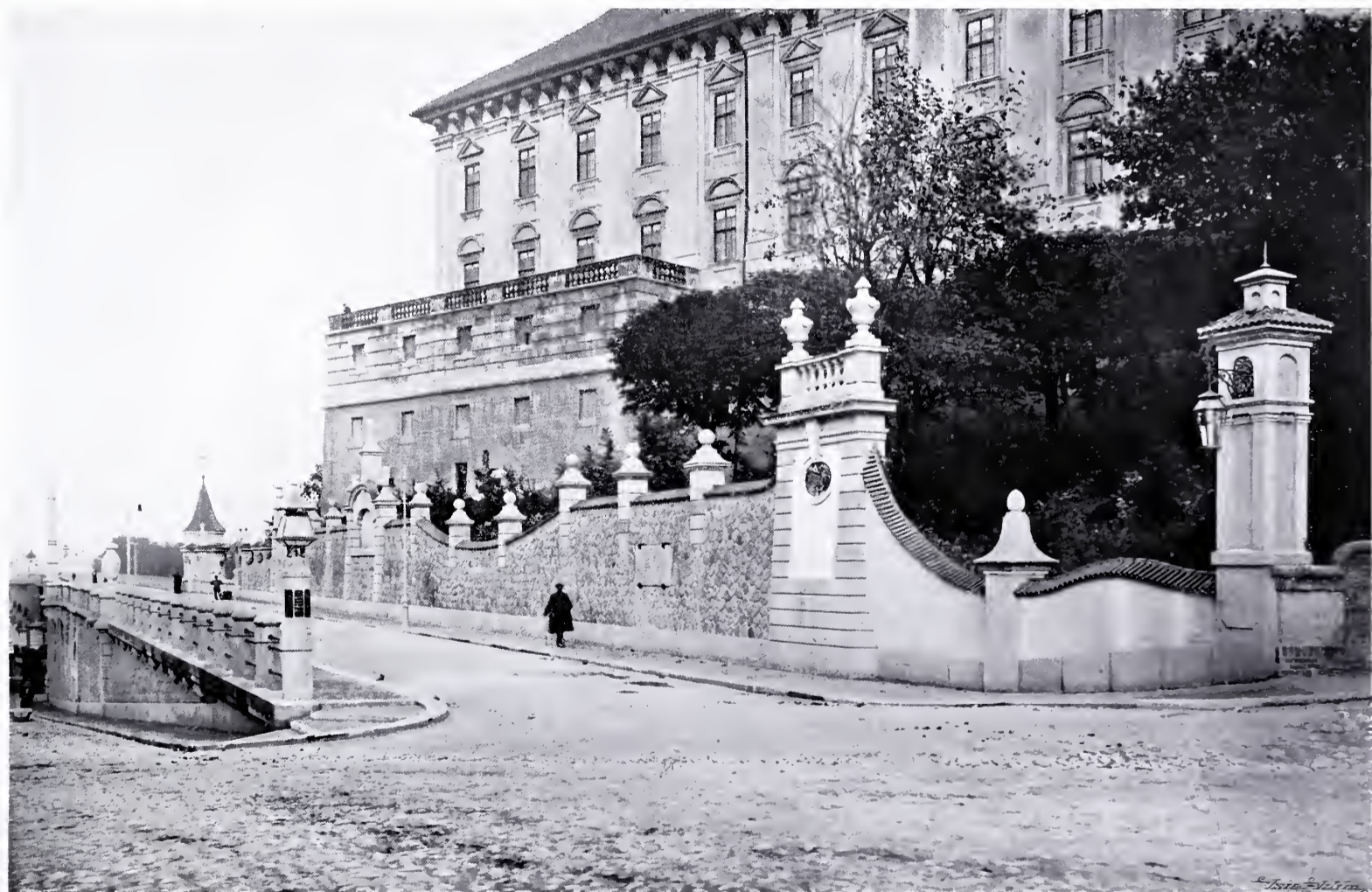
NOVÝ MOST PŘES LABE V ROUDNICI. -- SCHODIŠTĚ A RAMPA PŘI ZÁMKU. Architektonická úprava od arch. prof. J. Sandera.
