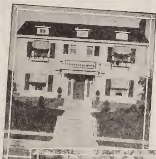
Residence of A. H. Taber 512 South Wilton Place L. A.
