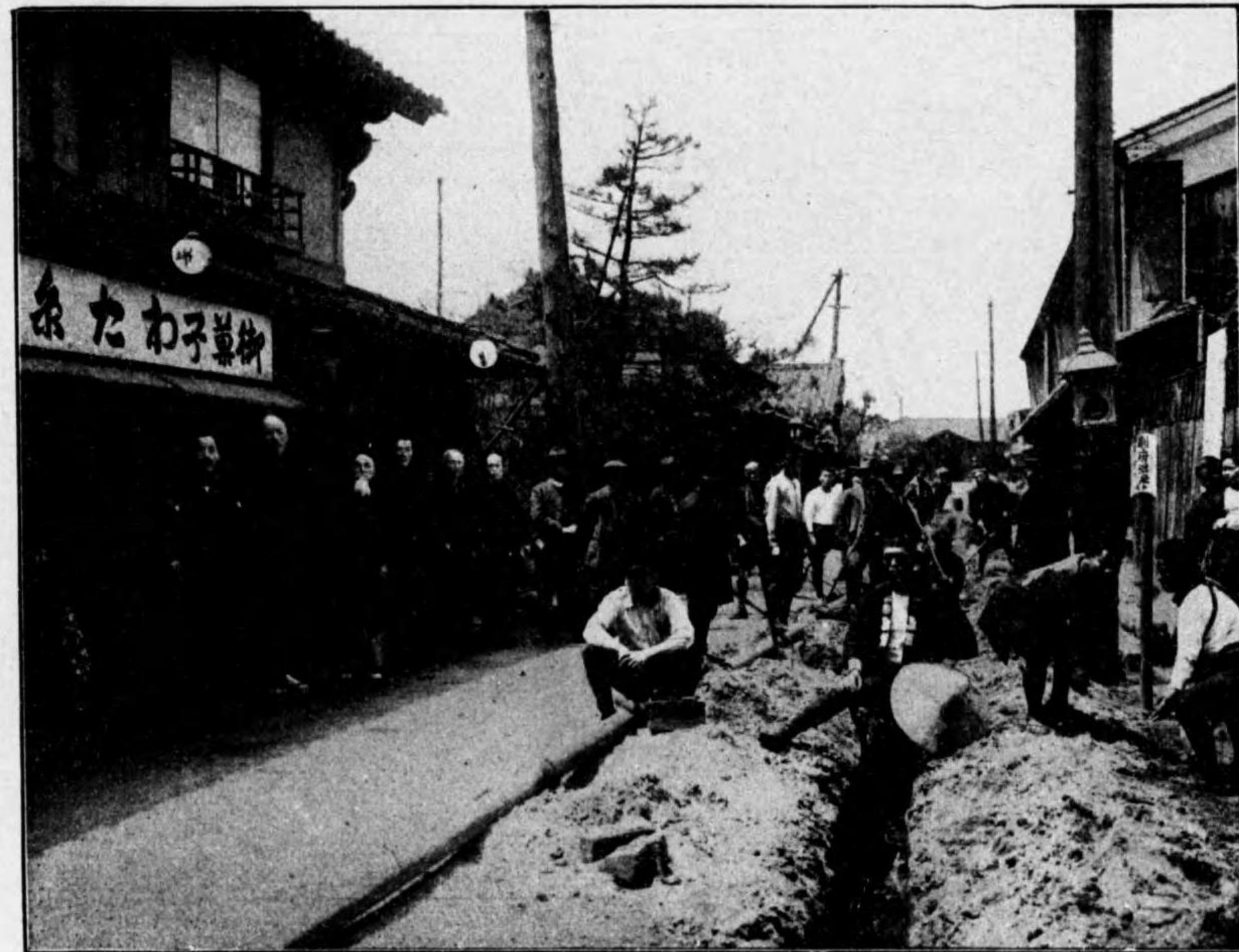
今宮村水道布設工事
