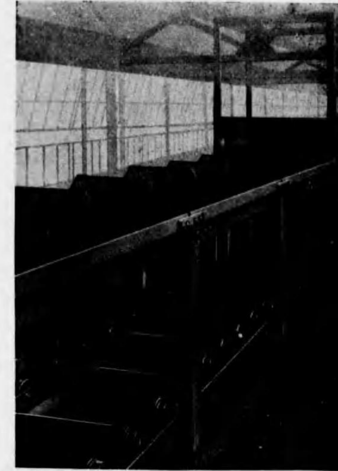
← 石炭の輸送に使用せる大型スクレーパ・フライト・コンベヤ
