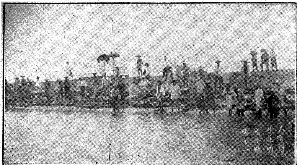
南昌大有圩牛尾閘搶險之况
