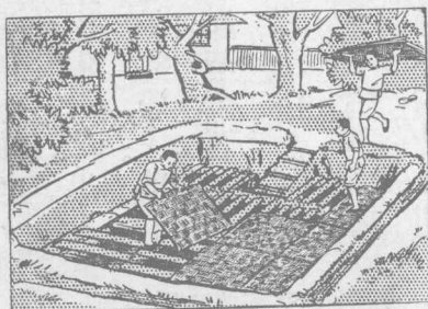
簡易地下室構造圖 | (二) 蓋頂
