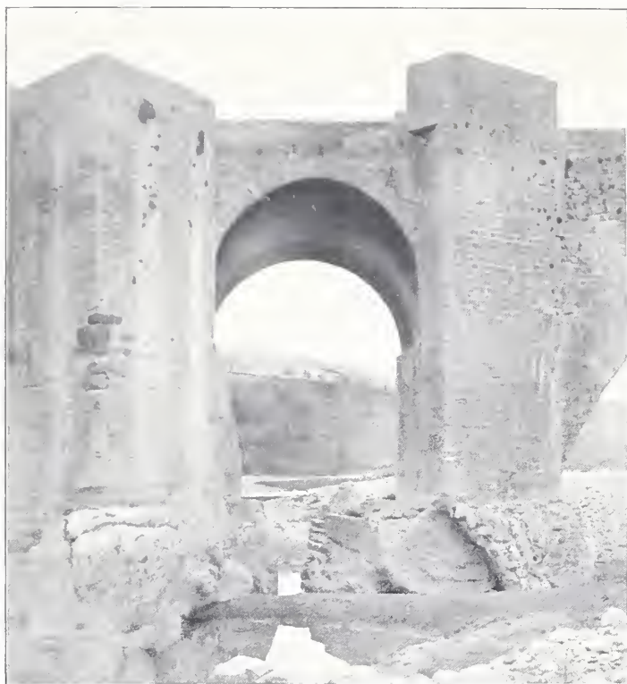
Die mittleren Pfeiler der Fluviabrücke
