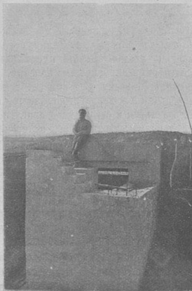
Австрійскій бетонный артиллерійскій наблюдательный пунктъ.
