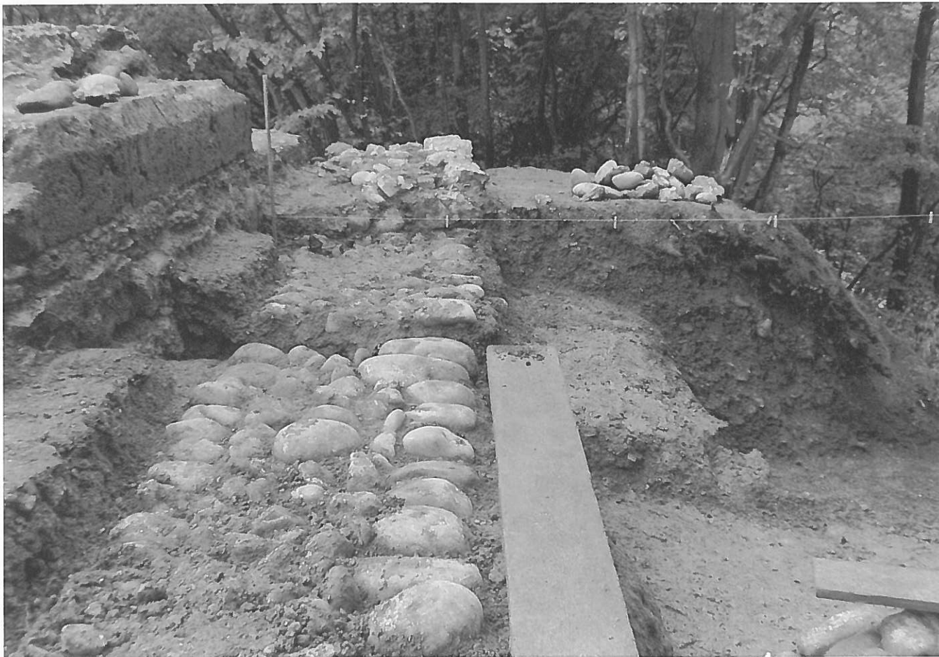
Nördlich des Turmes wurde die Fundamentlage einer älteren Mauer aus Feldsteinen freigelegt.
