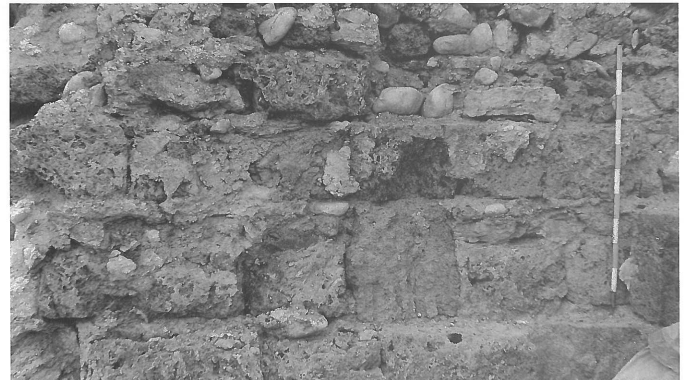
Ansicht der westlichen Innenwand des Turmes mit Resten der Tuffsteinverkleidung für die Tankzisterne.
