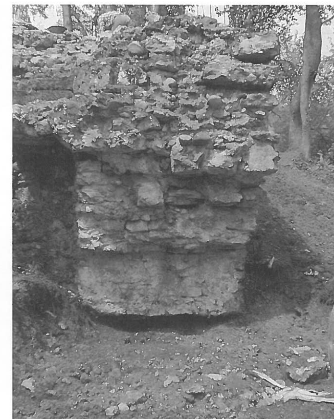
Ansicht der Stirnfläche der östlichen Turmmauer. Die im untersten Teil sichtbare glatte Mauerflucht gehört zur Nordmauer des Turmes. Das Fundament der Ostmauer setzt ca. 1 m höher an.
