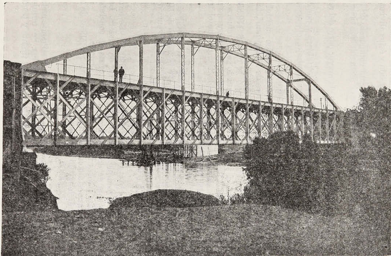
Puente Quepe con su refuerzo terminado
