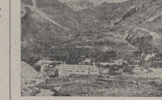
منظره عمومی از ساختمان خانه های مهندسین و کارگران معدن ذغال کاجره در حوالی کچر
