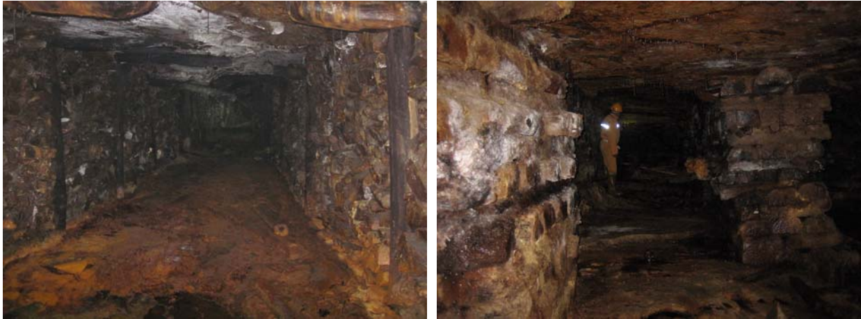
Figura 8 – Suporte com paredes de estéril Figura 9 - Suporte com pilhas de madeira
