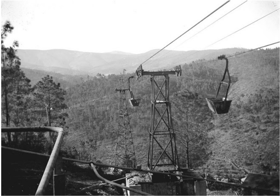
Figura 21 - Chegada do cabo aéreo à Lavaria do Rio
