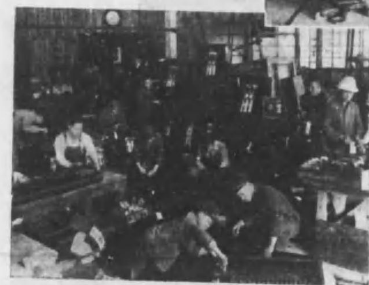
分電盤組立工場の一部
