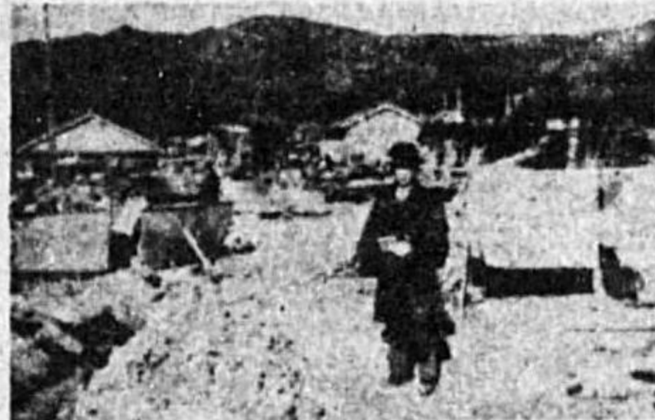
牟岐町海岸通りの被害
