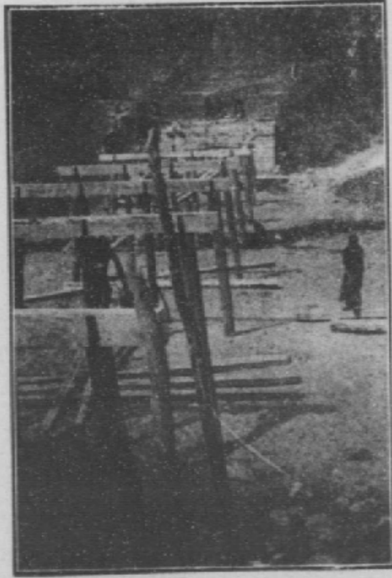
九洲河橋打樁情形
