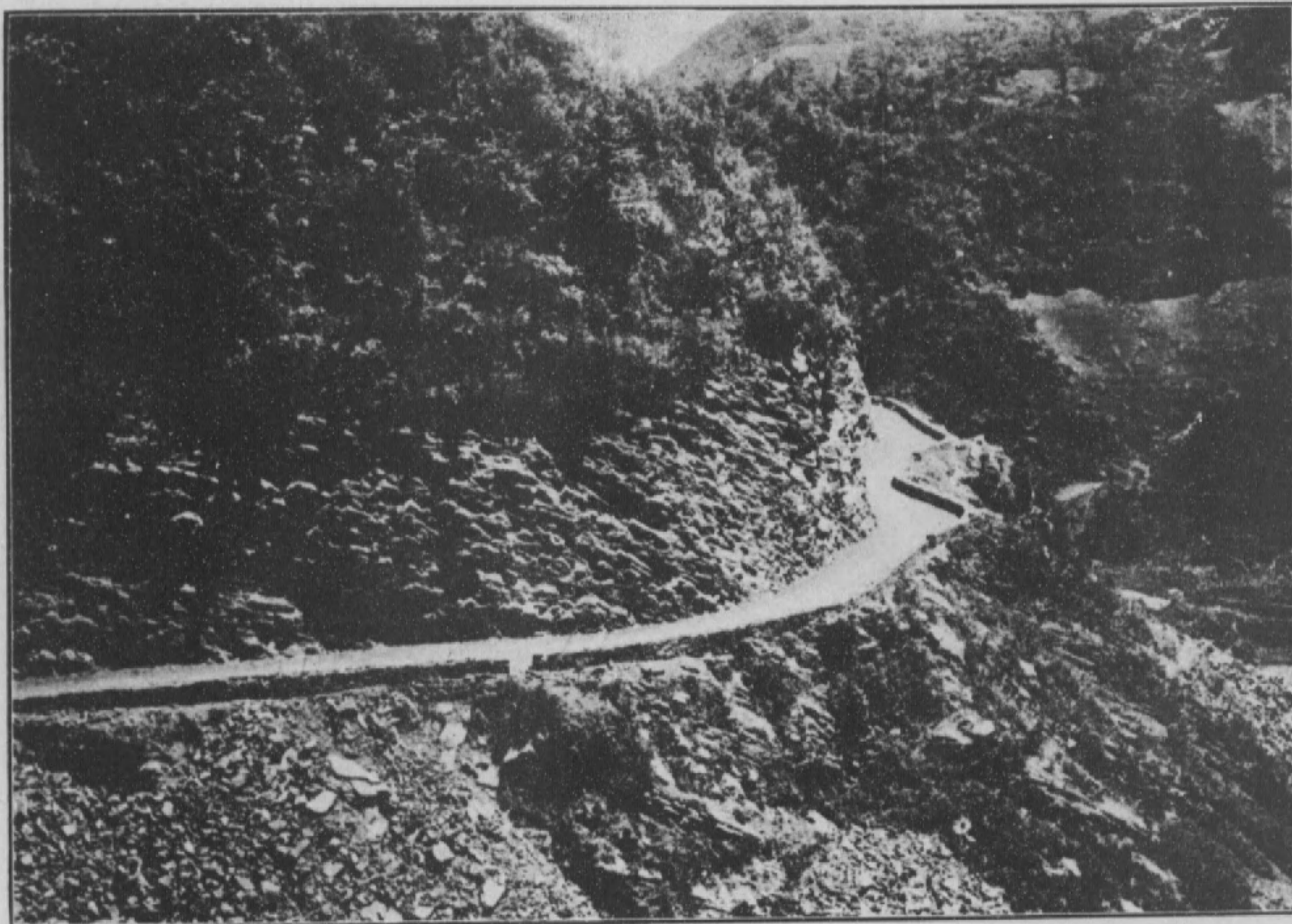
五丁關西坡開山路基(石方最巨之一段路寬4.5公尺)
