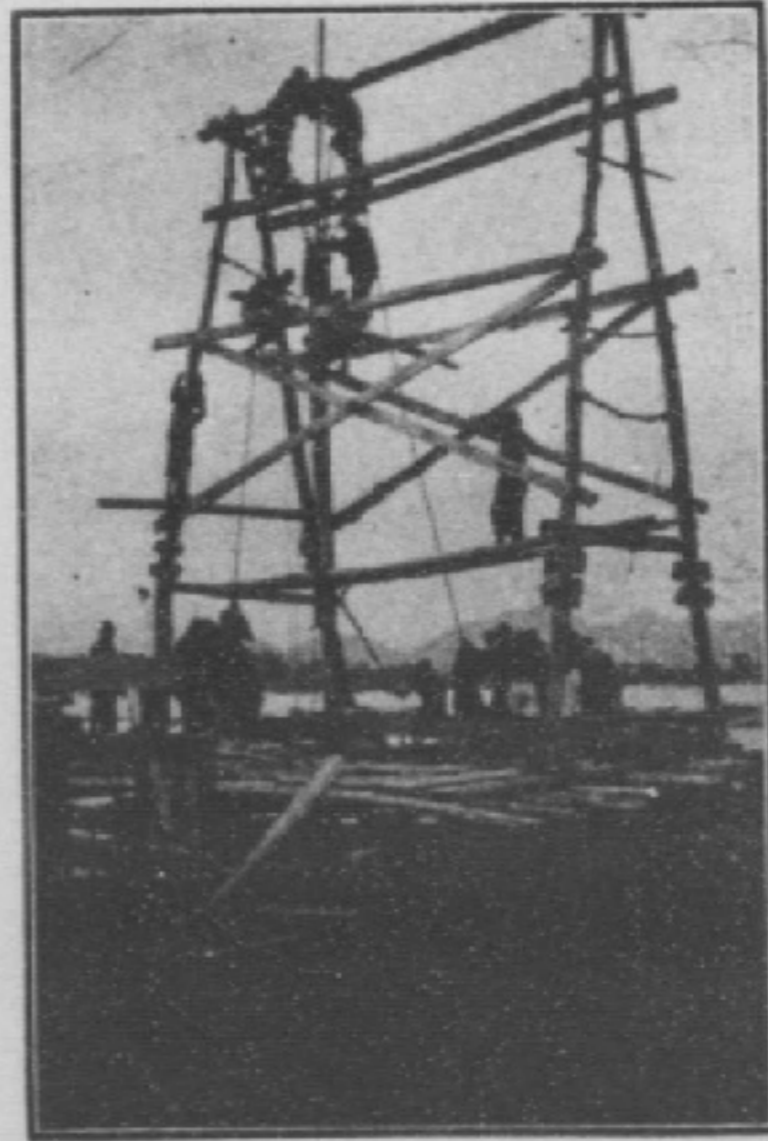
水磨河橋施工情形
