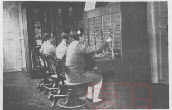
交換室總機及配線架
