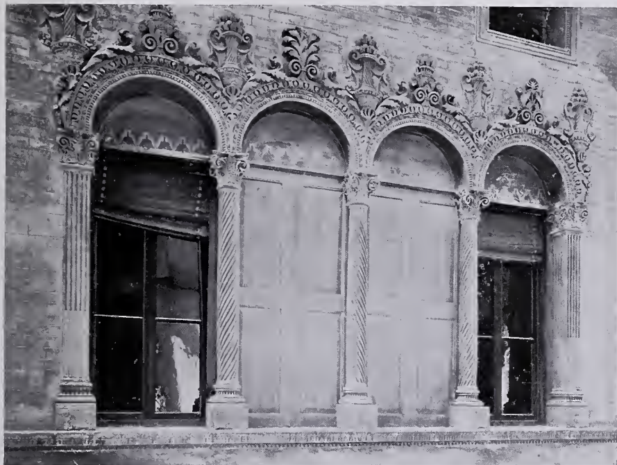
QUADRIFORA DI UNA CASA IN VIA ALTINATE.
