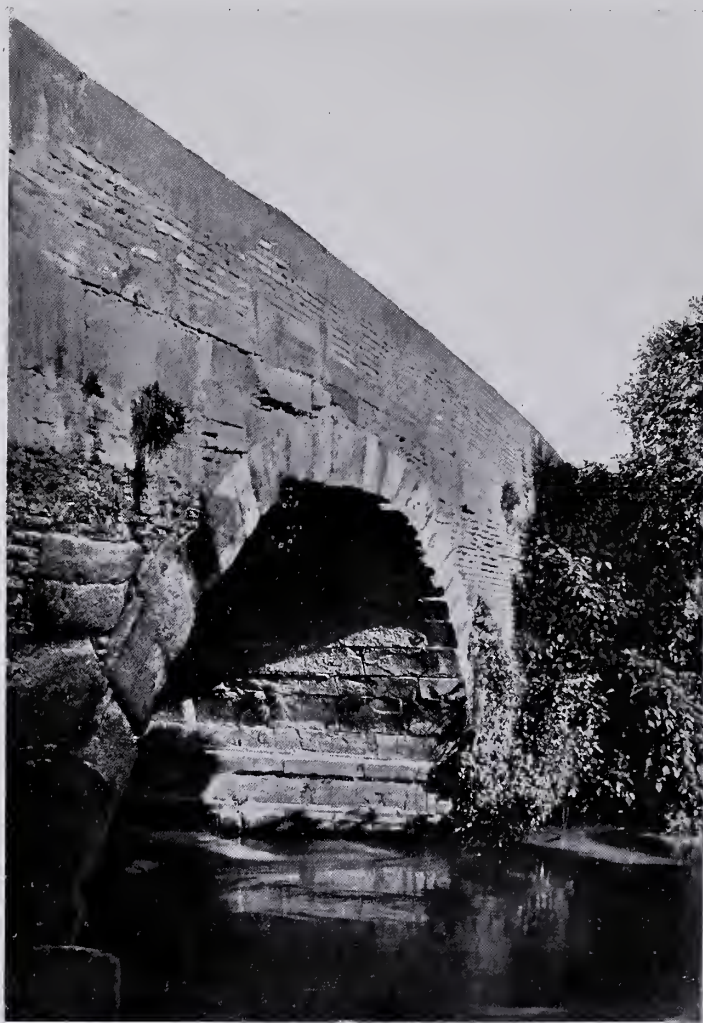
ARCO ROMANO DEL PONTE DI PONTECORVO.
