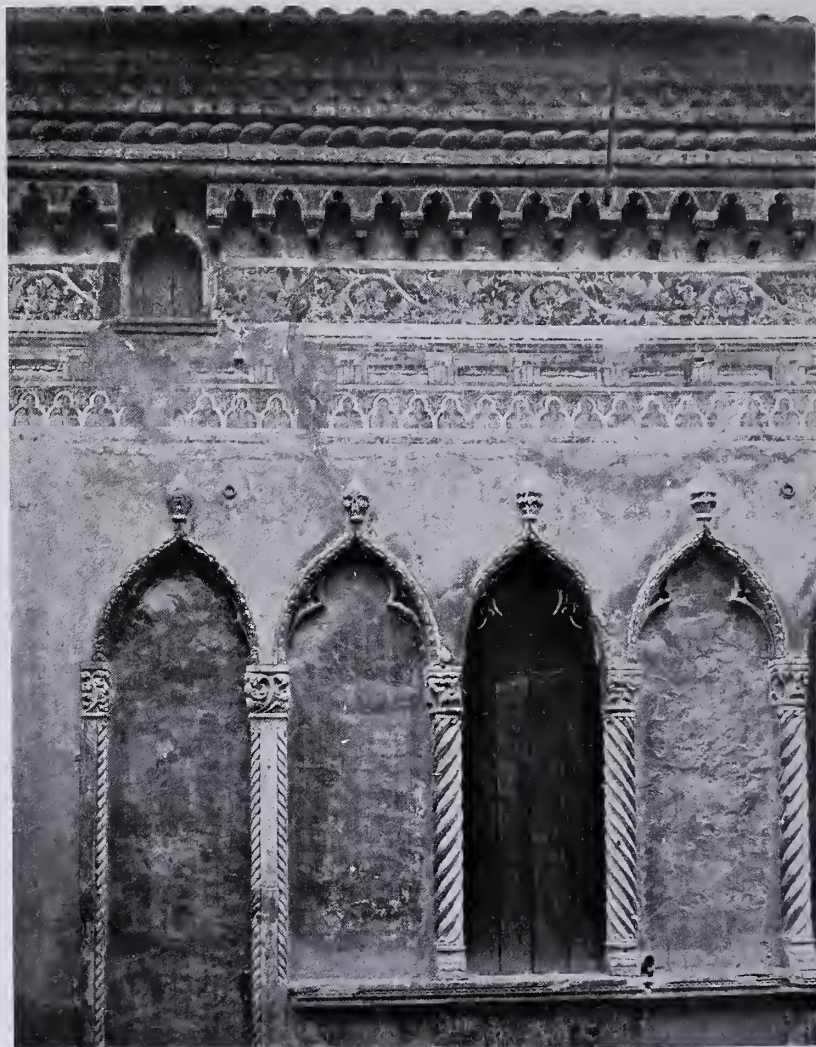
CASA CASALE IN VIA DEL SANTO — PARTICOLARE DELLA FACCIATA.
