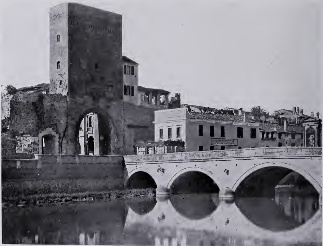
PONTE MOLINO SUL BACCHIGLIONE, CON VEDUTA DEI RESTI DELL'ANTICHE MURA.
