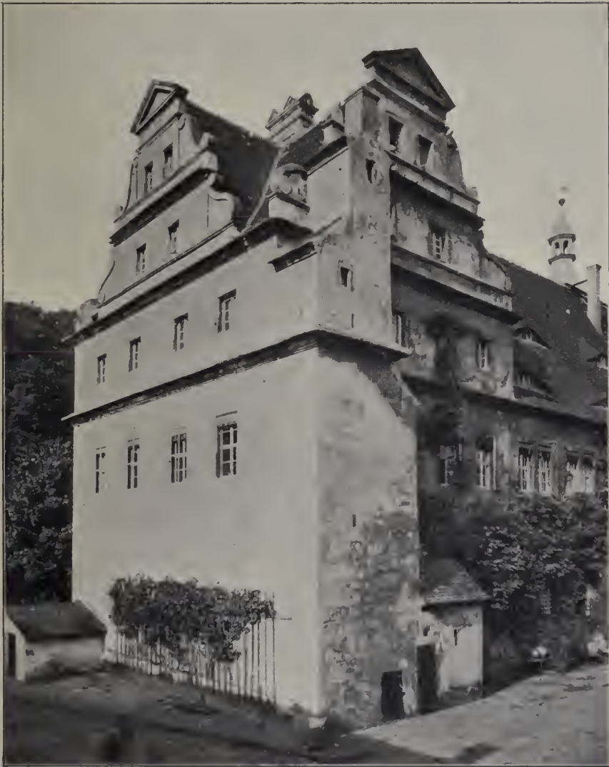
Fig. 546. Zabeltitz, der „Stall“, Kopfbau.
