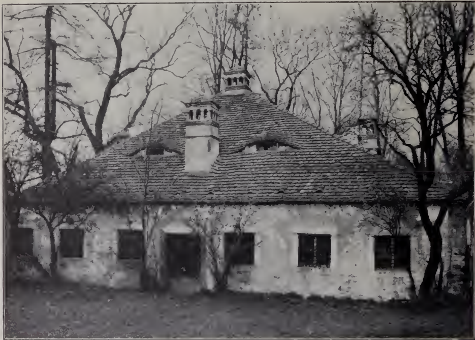
Fig. 587. Zottewitz, Gutshof, Pichschuppen.
