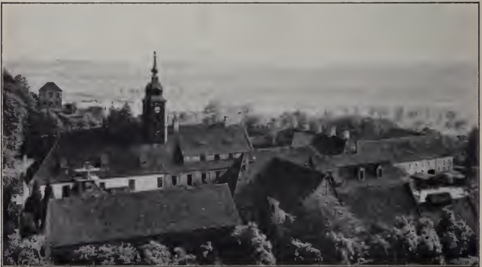
Fig. 417. Seußnitz, Schloß mit Kirche und Wirtschaftsgebäuden.
