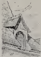
Fig. 317. Rödern, Kirche, Aufzugluke.
