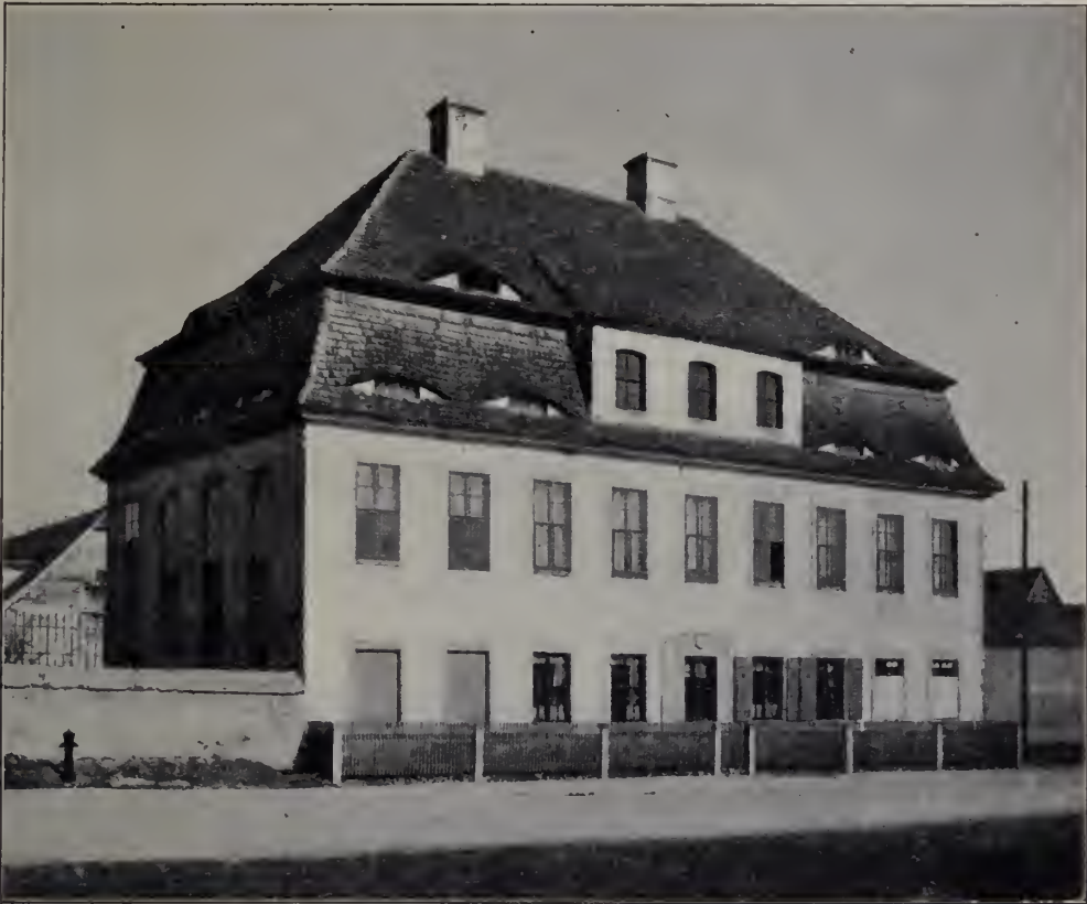
Fig. 236. Ponickau, ehemaliges Herrenhaus.
