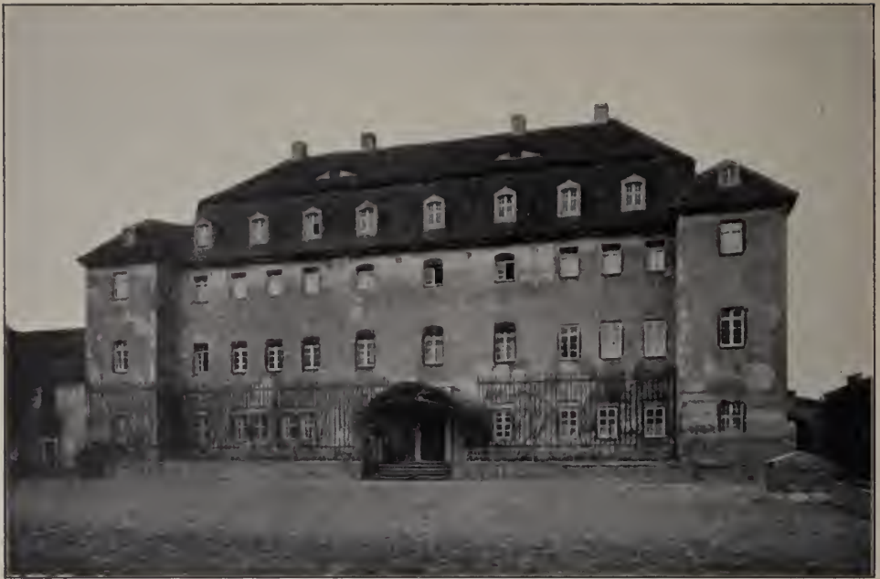
Fig. 604. Grödel, Herrschaftsgebäude, Hofansicht.
