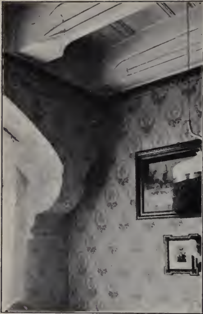
Fig. 416. Seußnitz, Torhaus, Balkendecke.
