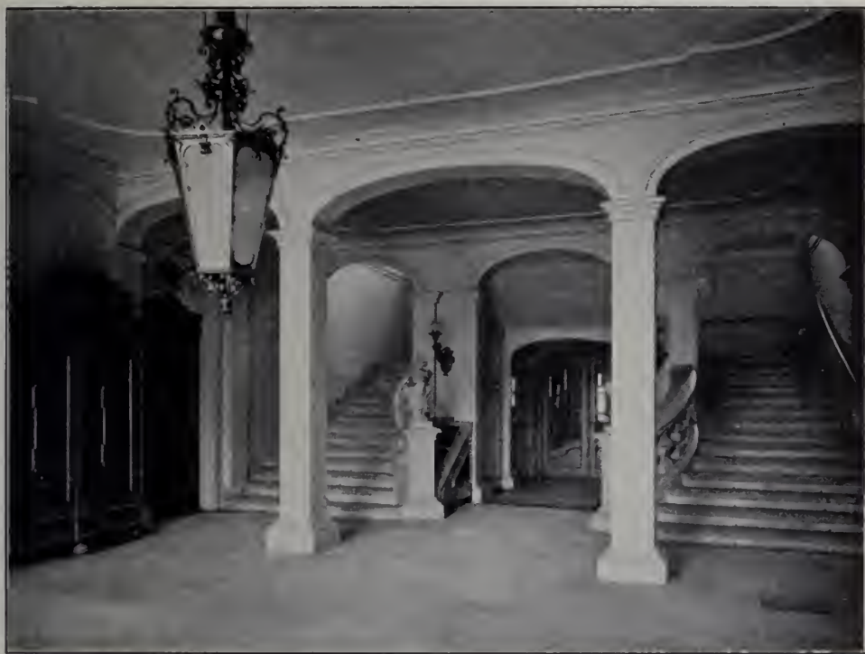
Fig 406 Seußnitz, Schloß, Flur im Erdgeschoß.
