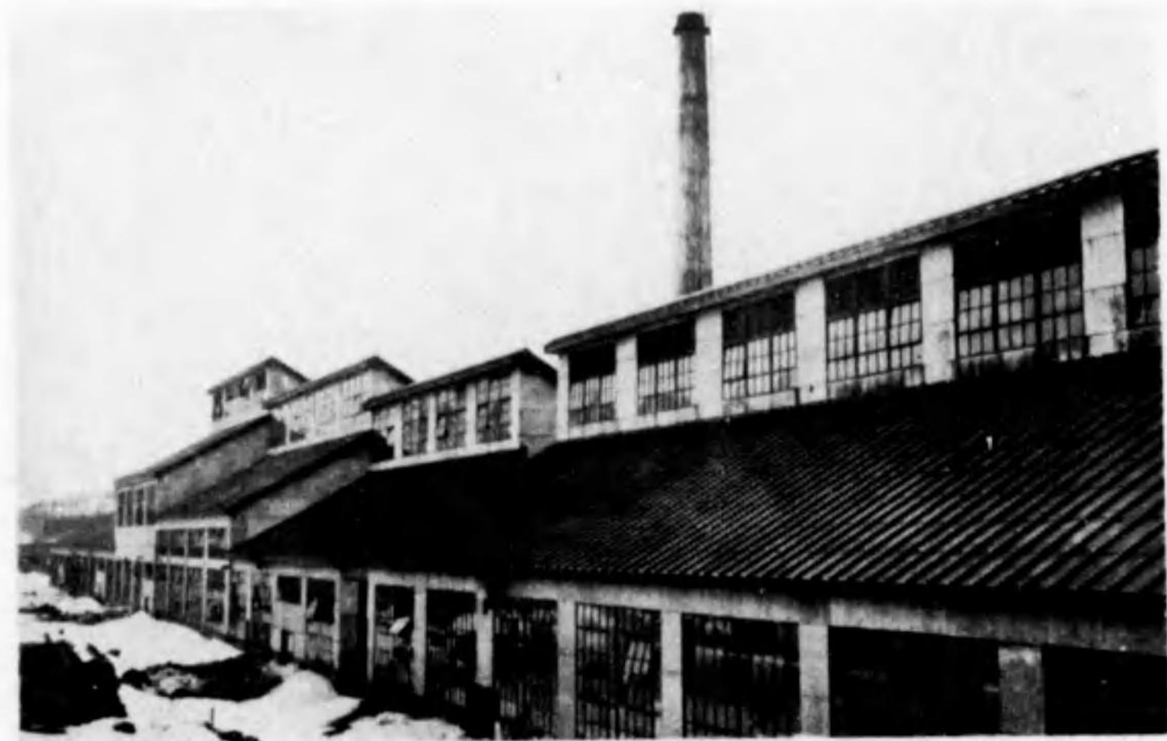
日本電興株式会社小國製造所工場の一部
