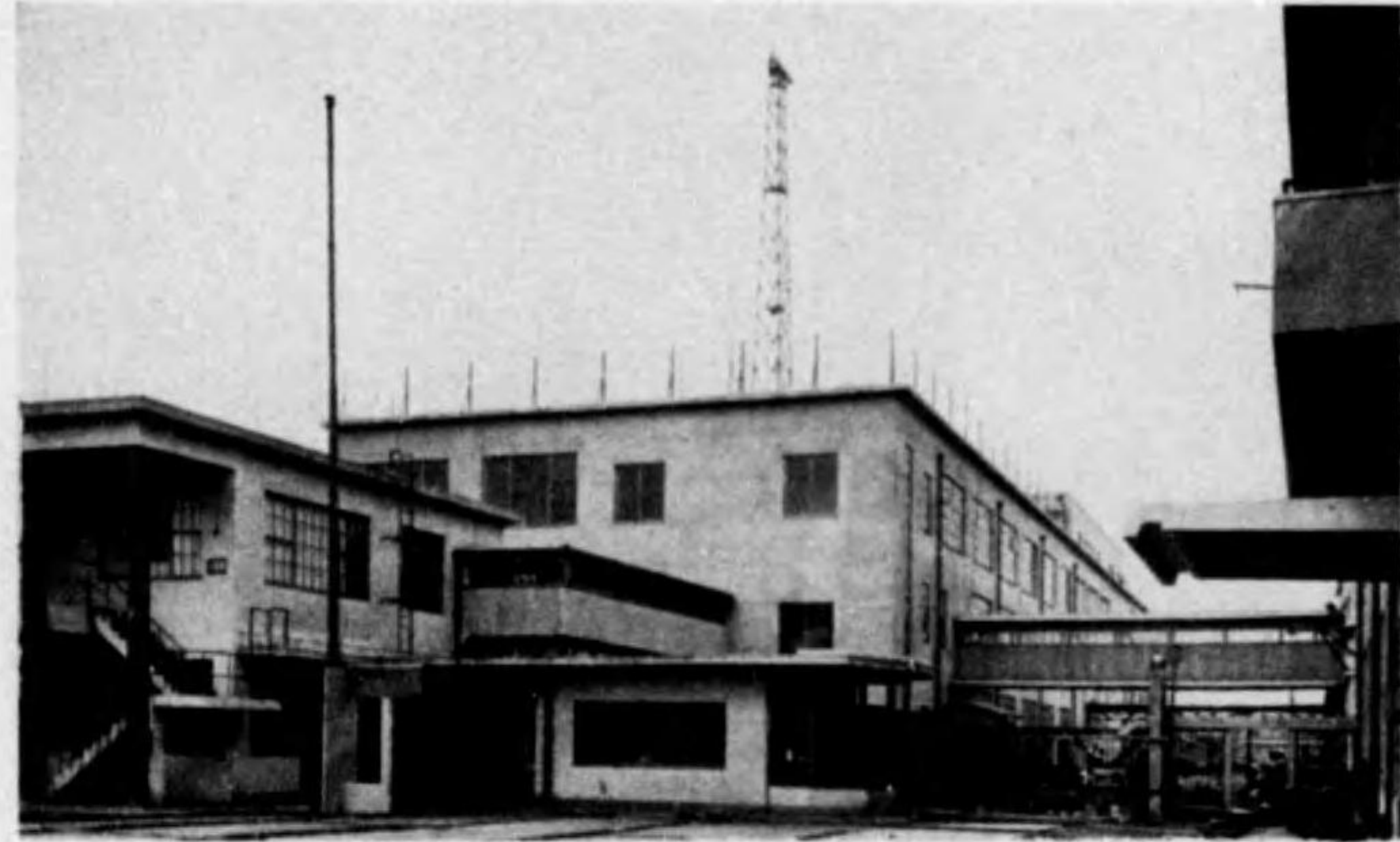
本社及び柳町工場
