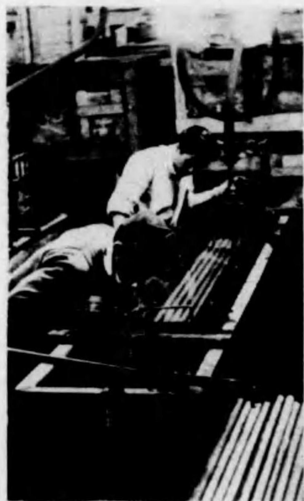
栓直作業の一部
