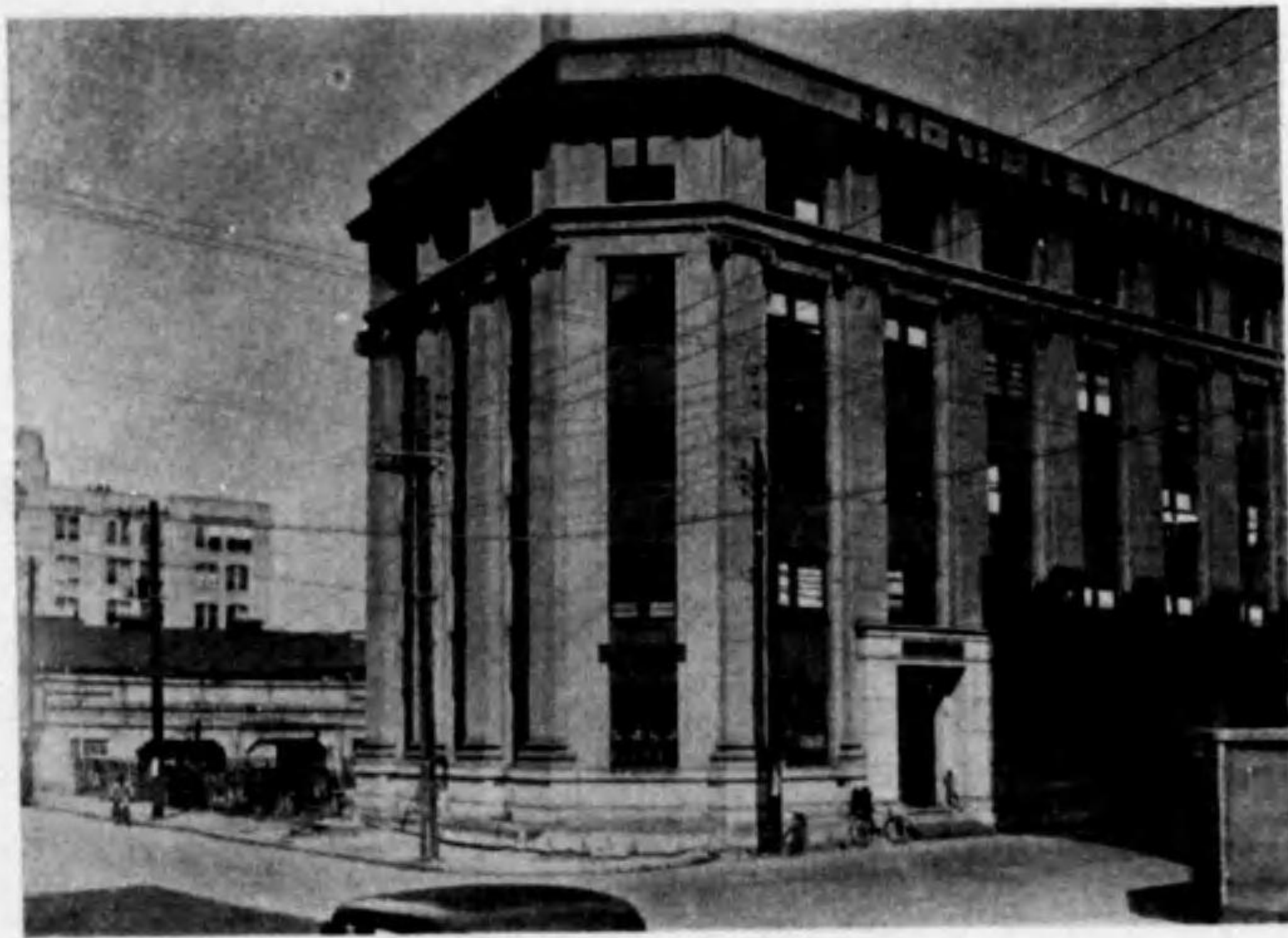
日本電気工事株式会社本社
