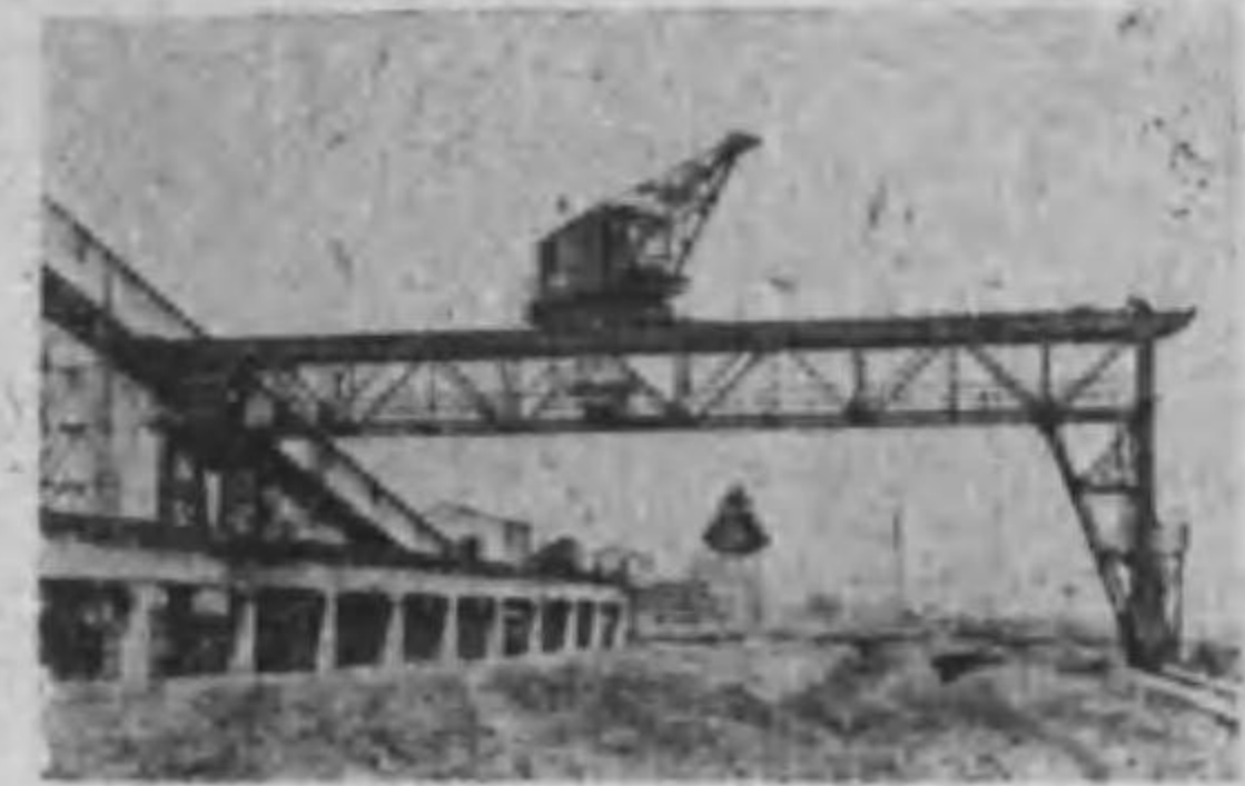
第2圖 3/4 階灰グラブ、ジブ起重機付ガントリー起重機
