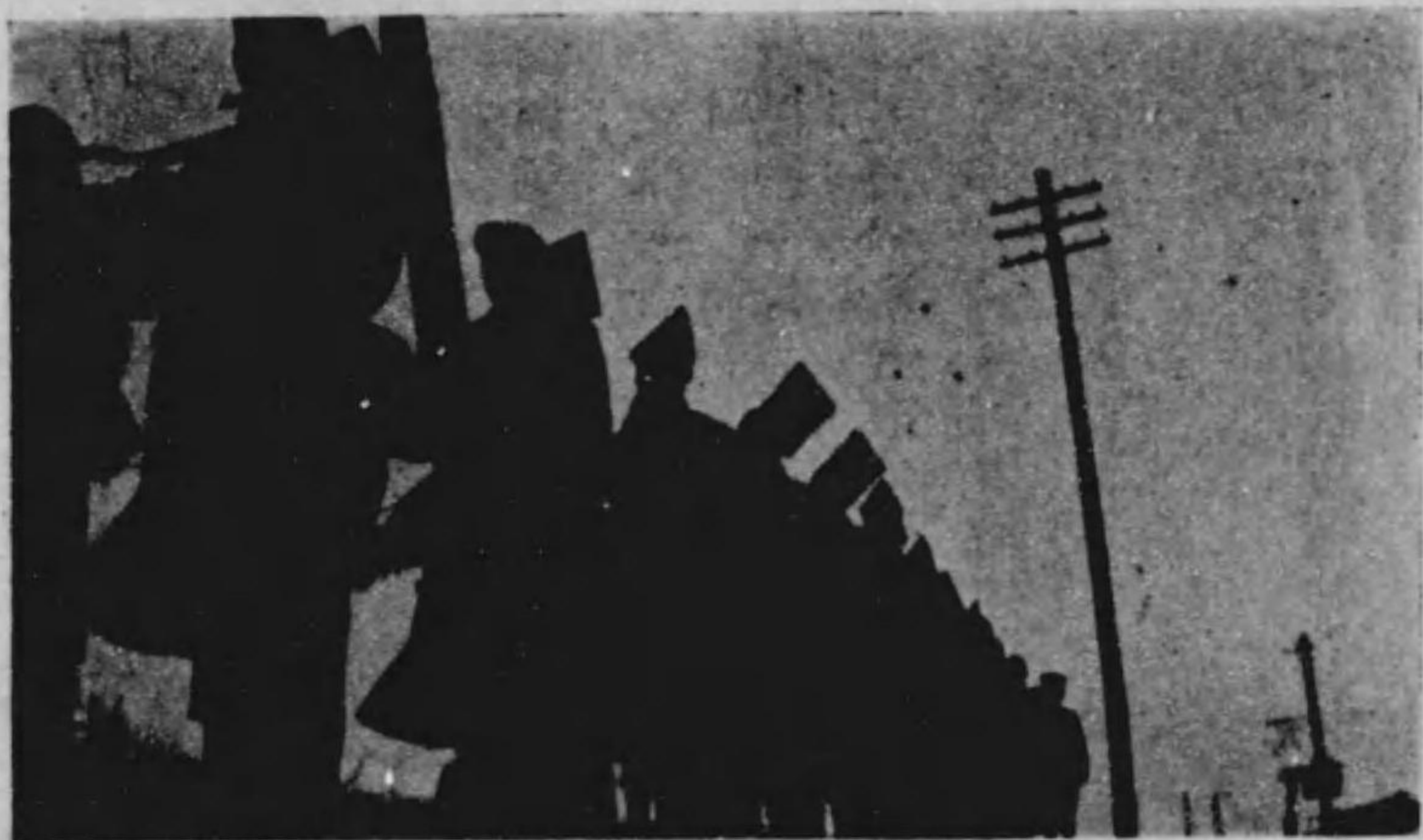
— 朝露踏んで作業現場 —
