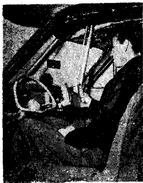
他在空中操縱設備駕駛汽車，左面是駕駛汽車用的駕駛盤，右面是飛行時用的操縱桿。
