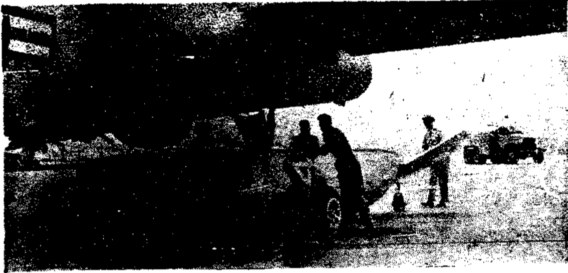
艇由三輪架移至飛機腹下裝載情形，艇首有安定面可作水平及垂直安定之用。
