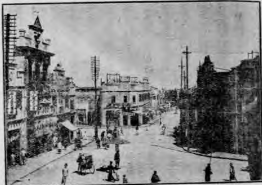
克成路尾橫馬路工程
