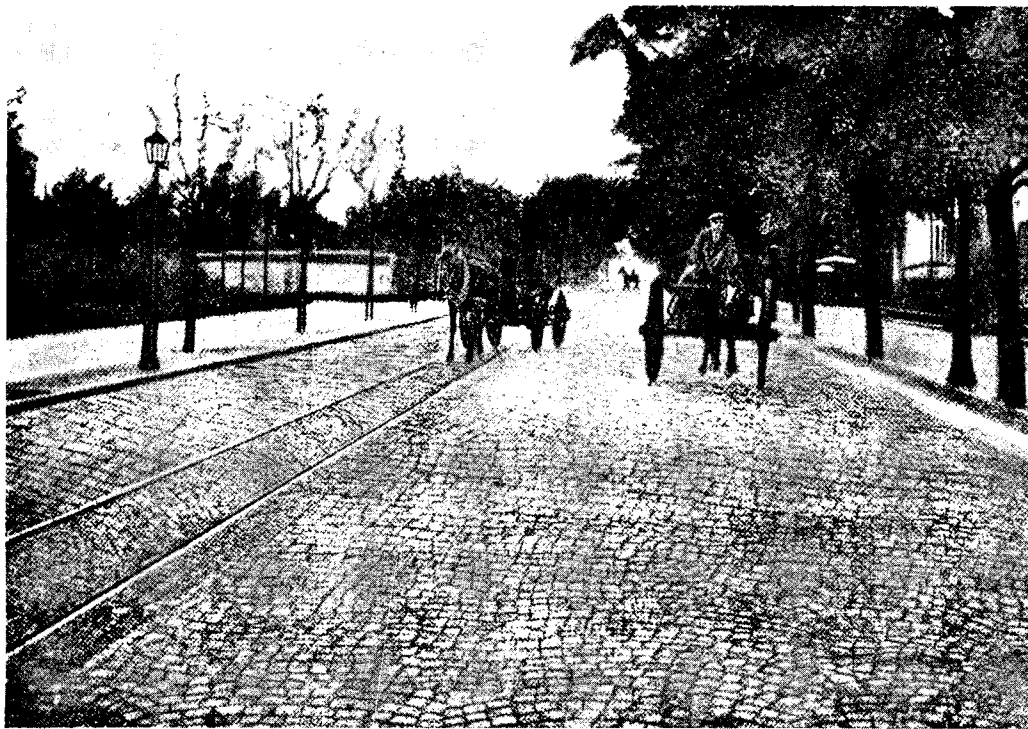
Рис. 5. Мозаиковая мостовая на дорогѣ изъ Висбадена во Франкфуртъ на Майнѣ.
