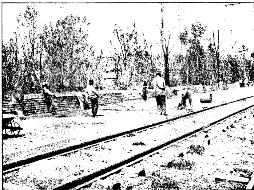
Рис. 7. Разсыпка песка.
