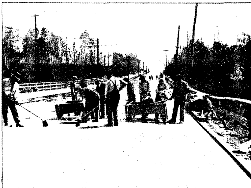
Рис. 13. Второе заполненіе швовъ.
