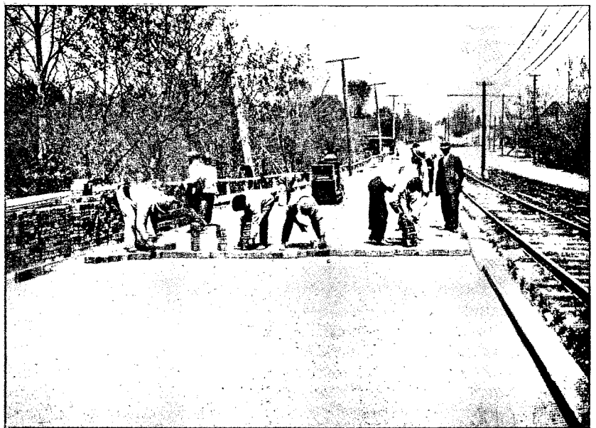
Рис. 9. Укладка кирпичей.
