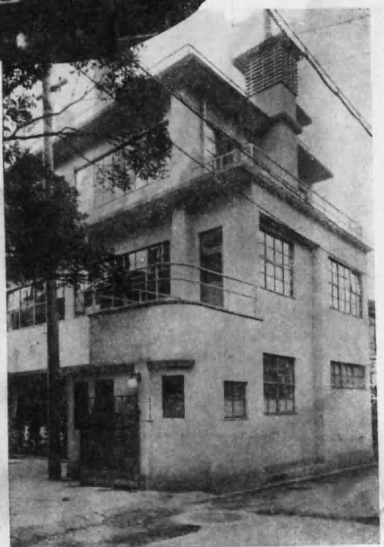
中村屋第二工場附屬食糧研究所
