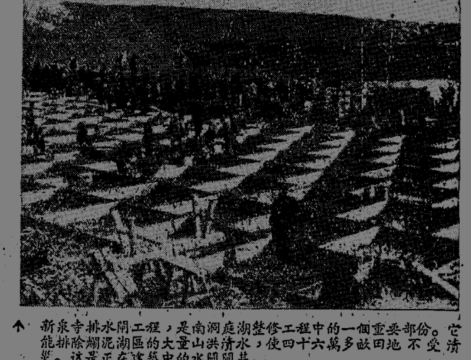
新泉寺排水閘工程，是南洞庭湖整修工程中的一個重要部份。它能夠排除湖區的大量山洪積水，使四十六萬畝回地不受水災。這是正在建築中的水閘開基。
