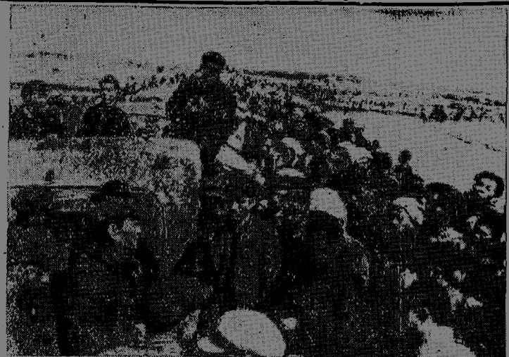
南洞庭湖整修工程的土方部分已經全部竣工了，剩下只是建築和保護性的護坡防汛工程。中南行政委員會和省政府組成的驗收團來到了工地，進行總驗收。這是程潛主席慰問民工們的情形。
