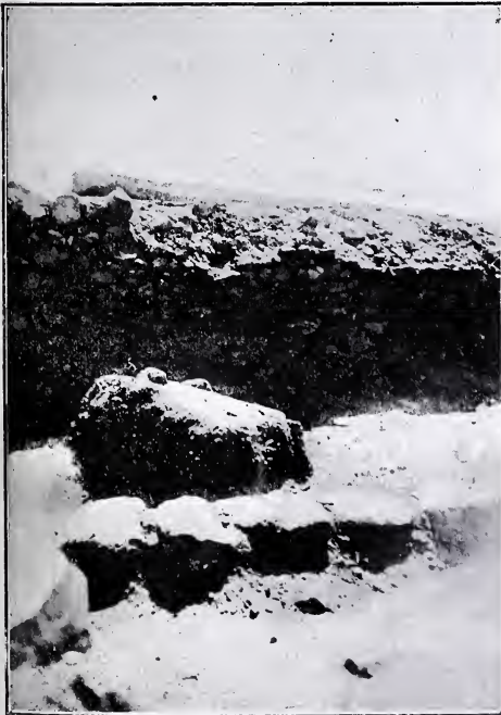
FIG. 2. a —MUROS CELTIBÉRICOS Y MUROS ROMANOS
