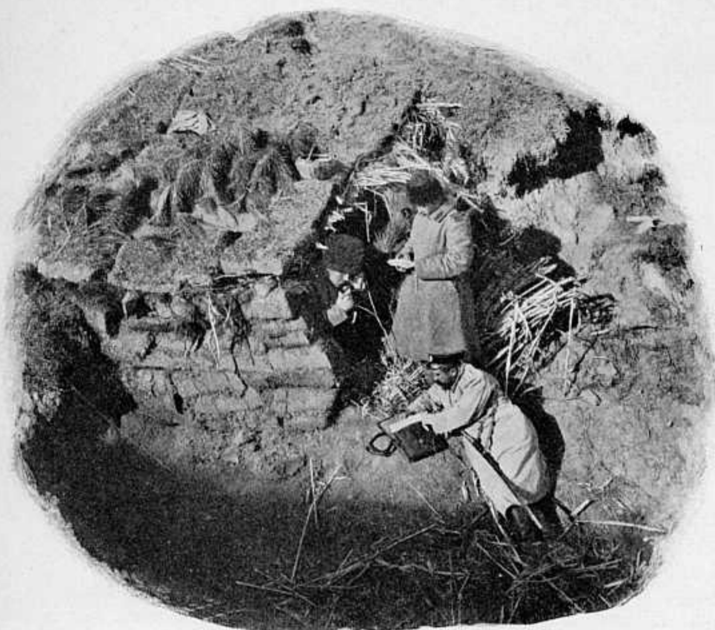
ТЕЛЕФОННАЯ СТАНЦИЯ НА ПЕРЕДОВОЙ ПОЗИЦИИ ЭРДАГОУ. ПО ФОТОГРАФИИ В. ВУЛЛА, СЪ ТЕАТРА ВОЙНЫ.
