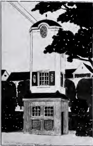
Abb. 1. Transformator-Station. Entwurf von Heint. Müller, Thalwil.
