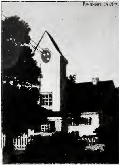
Abb. 3. Transformator-Station. Entwurf von Heint. Müller, Thalwil.
