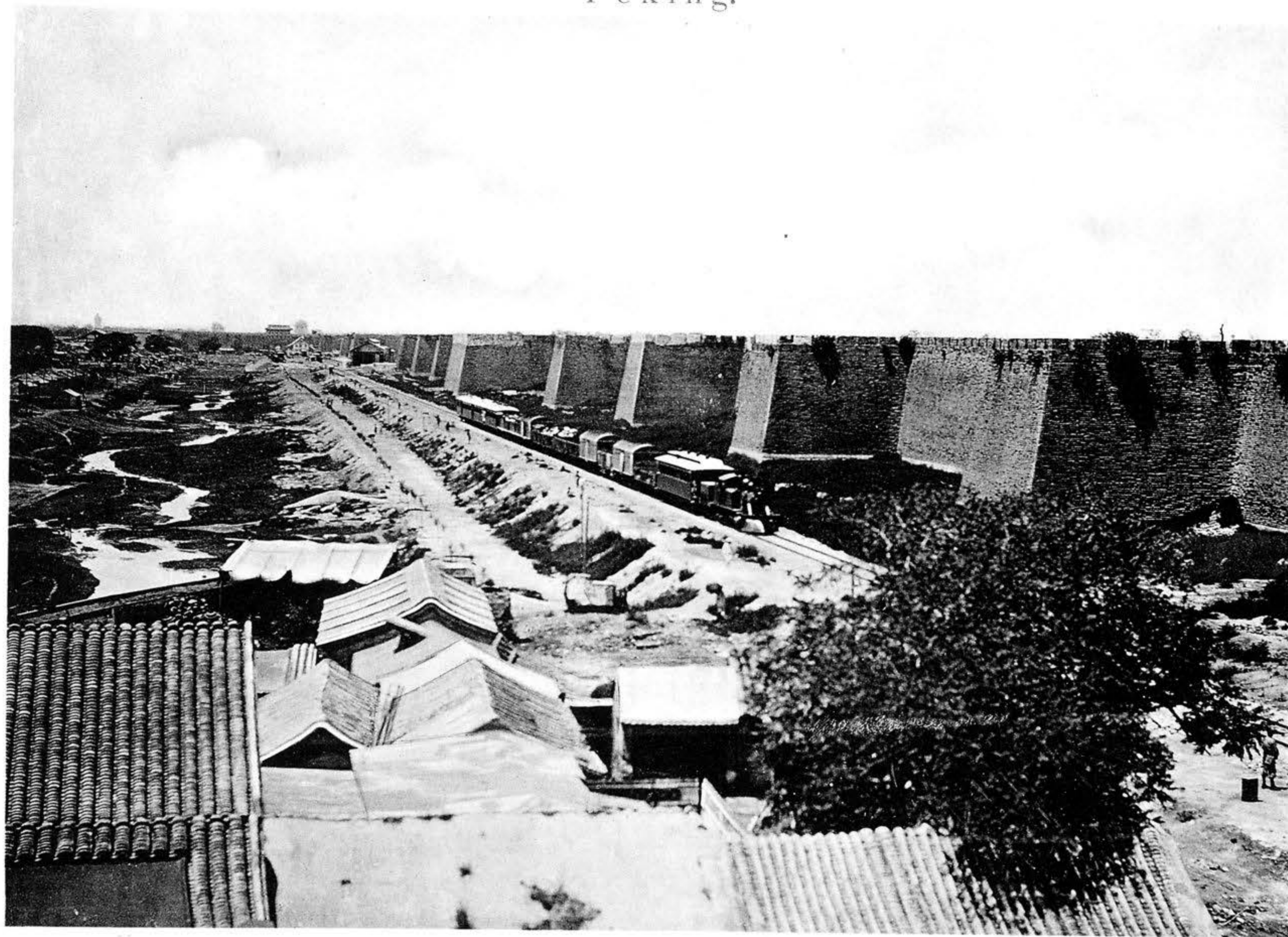
Die Peking-Tientsin-Bahn an der Tartarenmauer.
