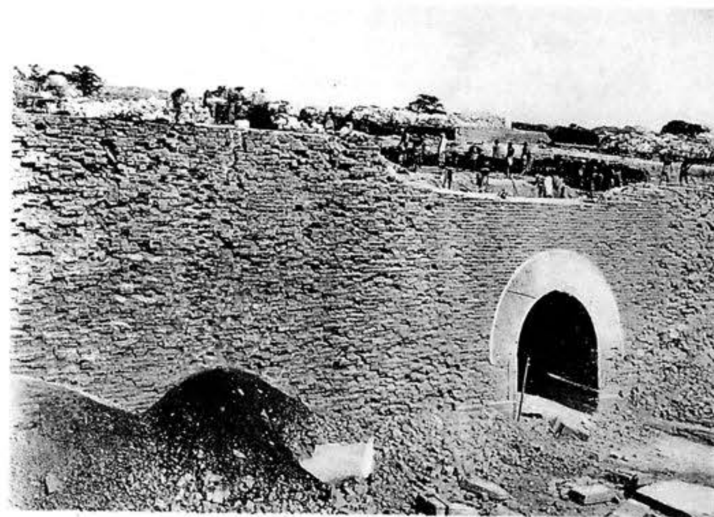
Durchbruch im Hatamén.
