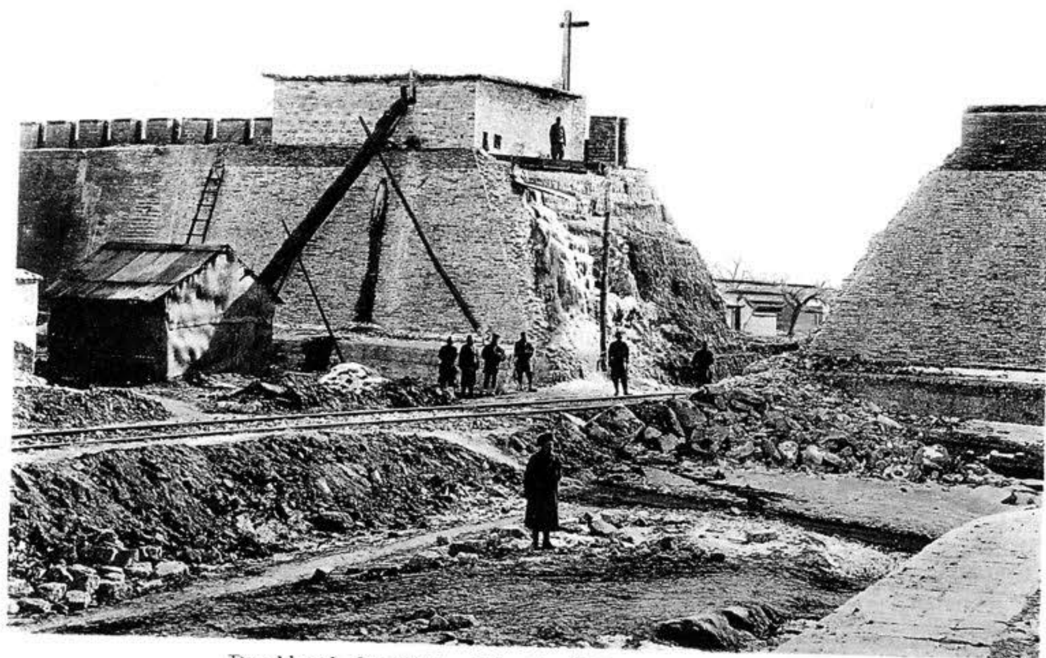
Durchbruch der Peking-Tientsin-Bahn in der Südmauer.
