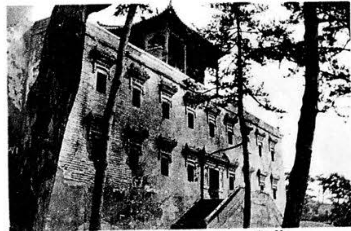
Massive Basis der Haupthalle.
