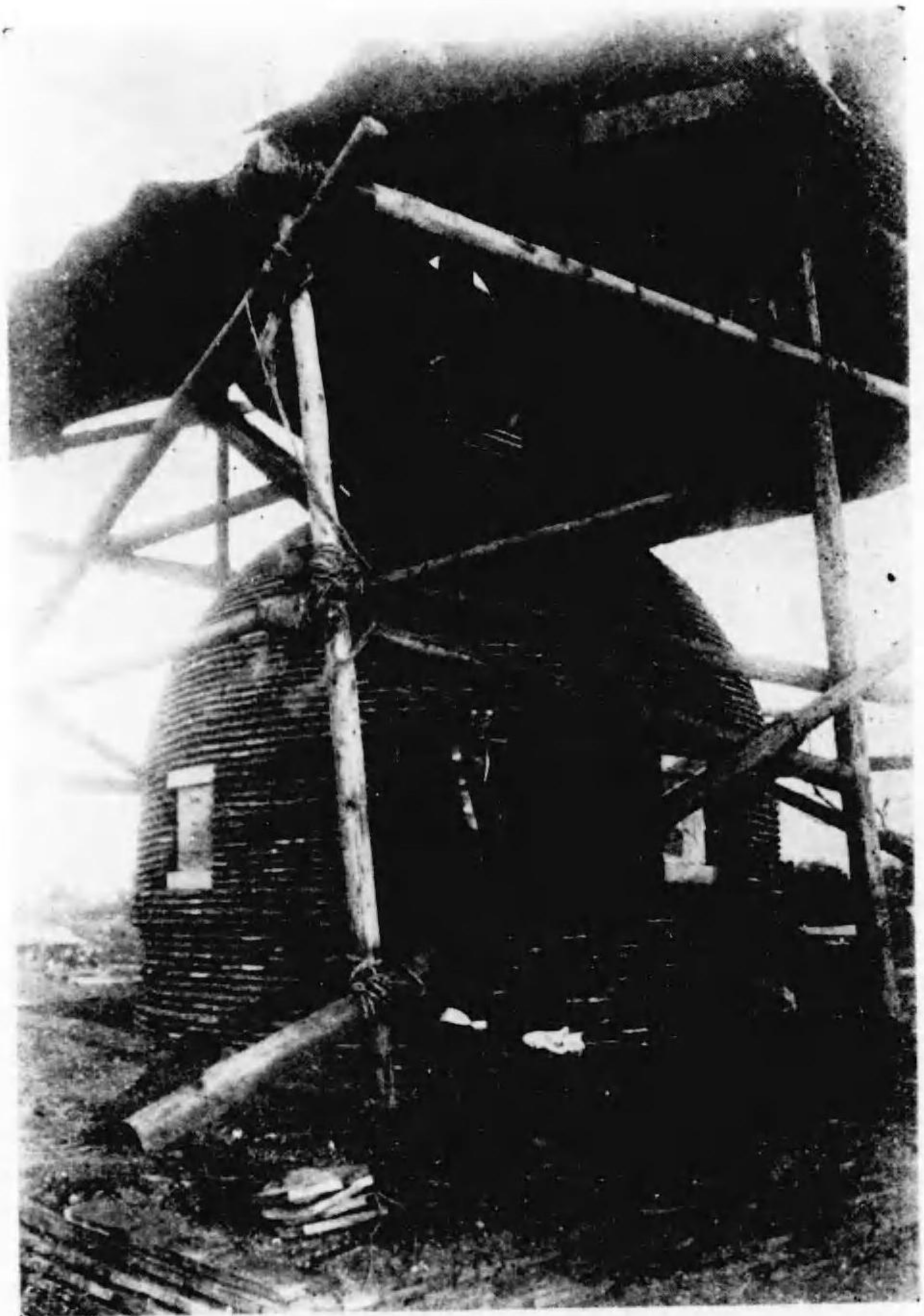
五〇, 建設中の塙塔 其六 (昭和二十一年九月時正日六時五十四分)
