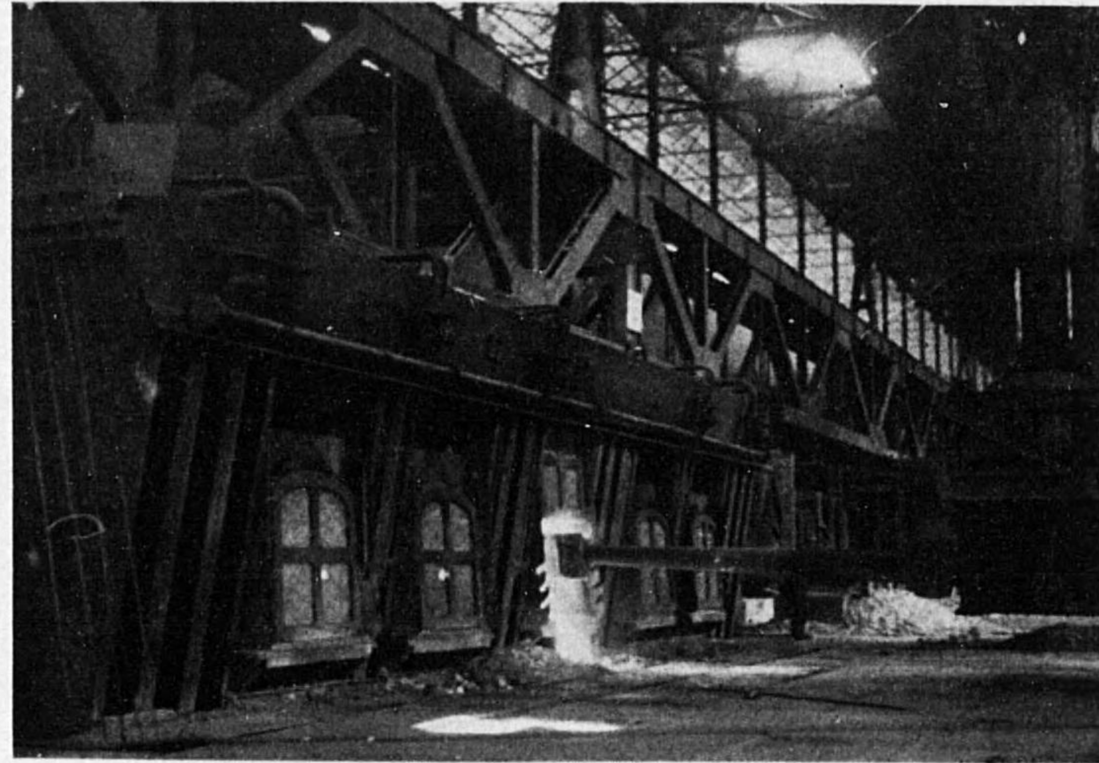
6月5日 昭和製鋼所工場内部 (北里)
