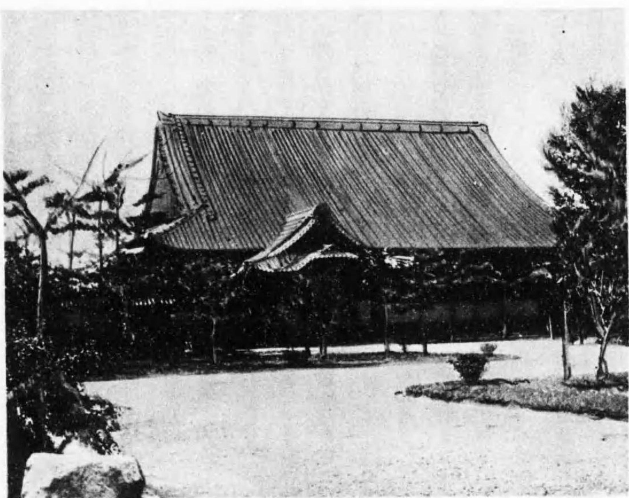
千疊閣跡の建物 此は大坂城中千疊閣跡の建物にして明治十八年中紀州和歌山城にありしものを此處に移す全部檜材なり
