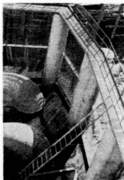
(六) 日暉港嘔水站工程(2)
