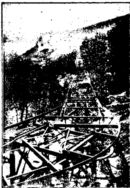
高架單棧空運站設備(運水坭用) (Transporteur-Monocable)
