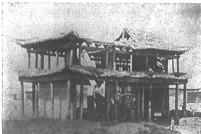
甘肅固原前提督署賞門地震後塌壞
