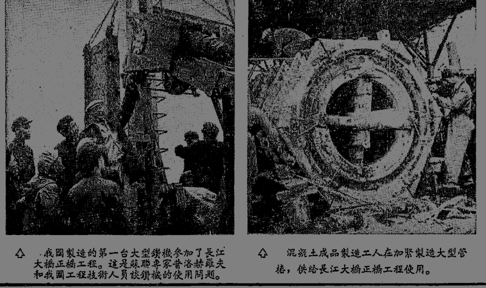
我國製造的第一台大型鑽機參加了長江大橋正橋工程。
